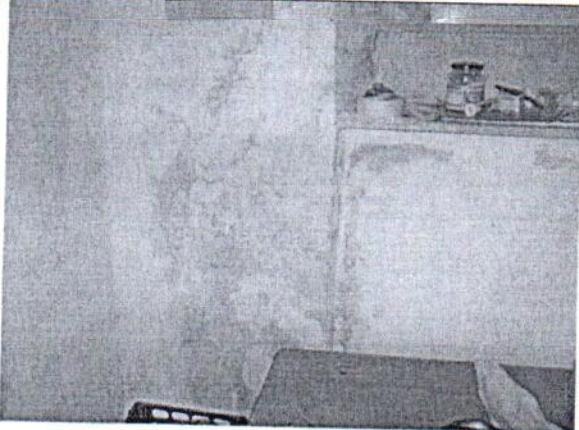
UMIDITA' DI RISALITA' CAPILLARE PIANO TERRA
