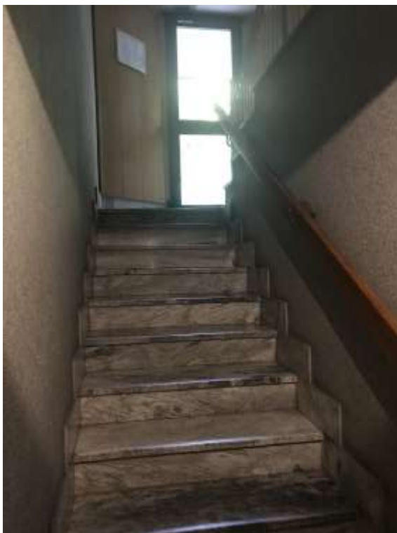
Foto 4. Vista delle scale che collegano i diversi livelli del fabbricato.
