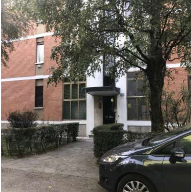
Foto 3. Vista del fabbricato inquadrato dall'esterno con al centro l'ingresso all'edificio.
