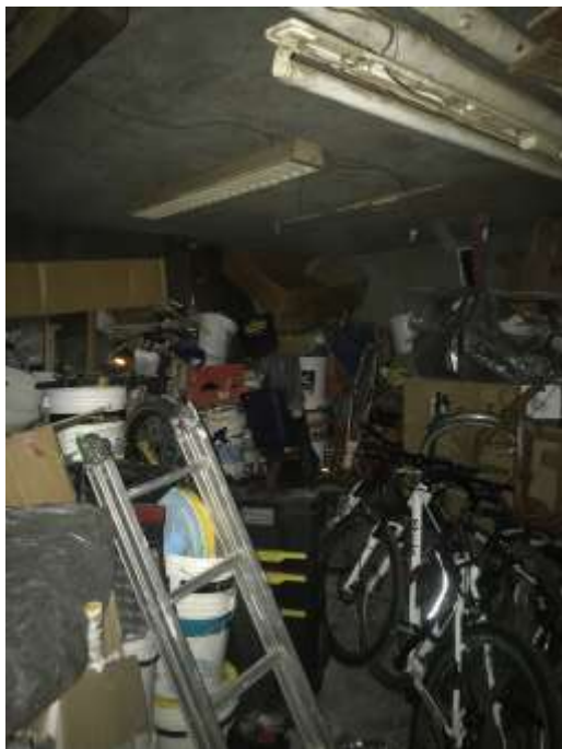
Foto 19. Vista dell'interno della cantina.
