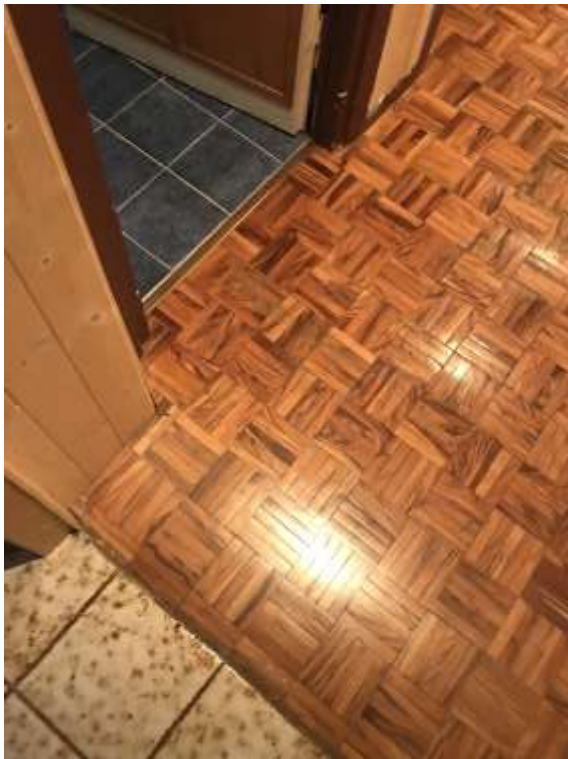
Foto 10. Dettaglio della pavimentazione del corridoio.
