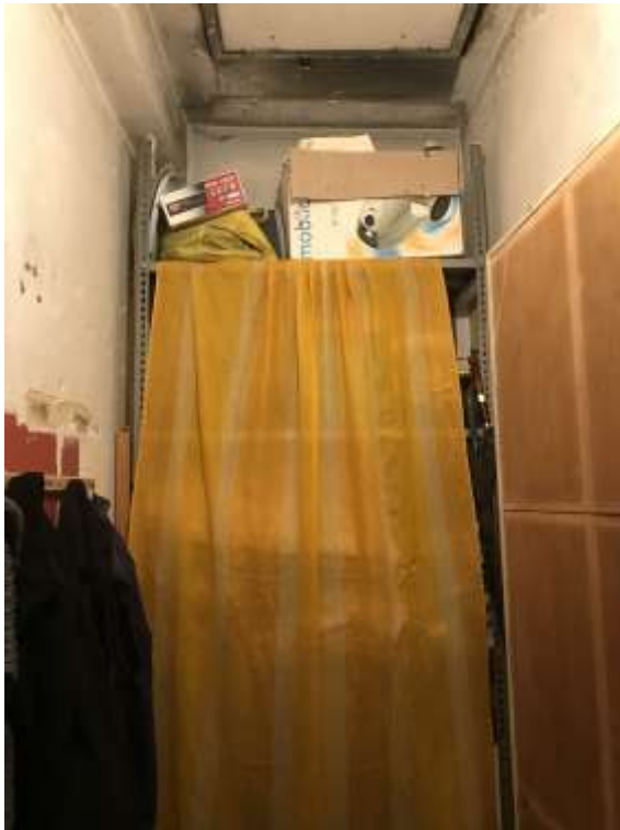
Foto 15. Vista del ripostiglio.
