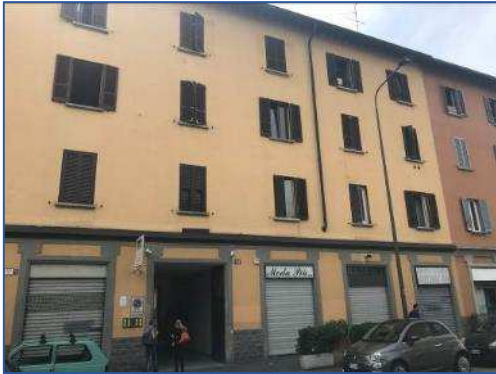
Foto 1 - immobile di via Varesina 199
