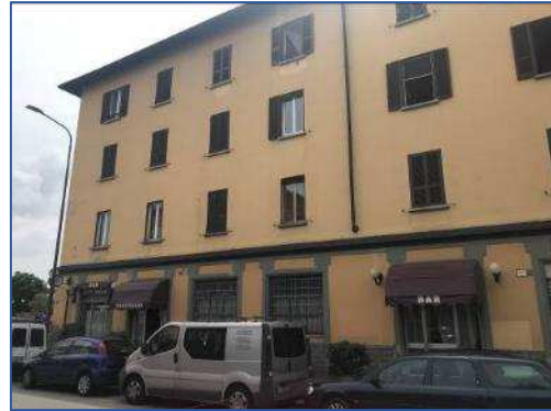
Foto 2 - immobile di via Varesina 199
