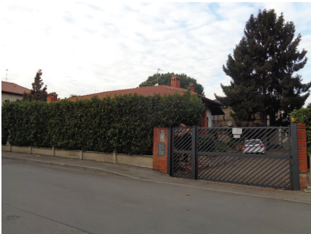
Immagine. 1. Vista da strada
