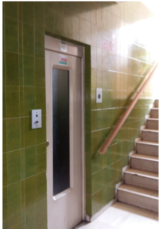
Viste atrio d'ingresso e vano scale
