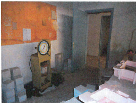
Blocco servizi interno.
