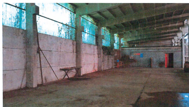
Area lavorazione ferri.
