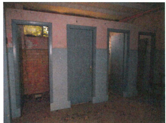
Blocco servizi interno.
