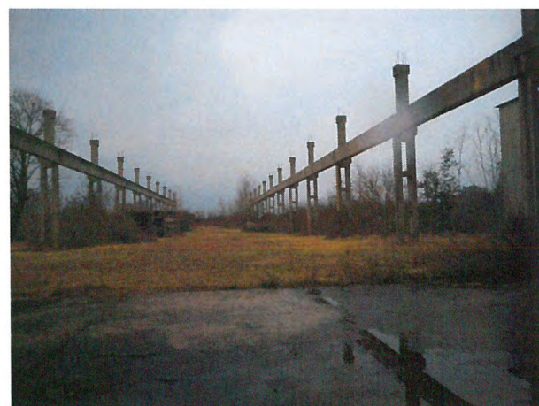
Strutture scarico pezzi a servizio del carroponete.
