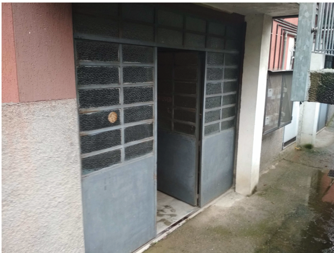
Foto n. 12 – Ingresso piano cantinato
