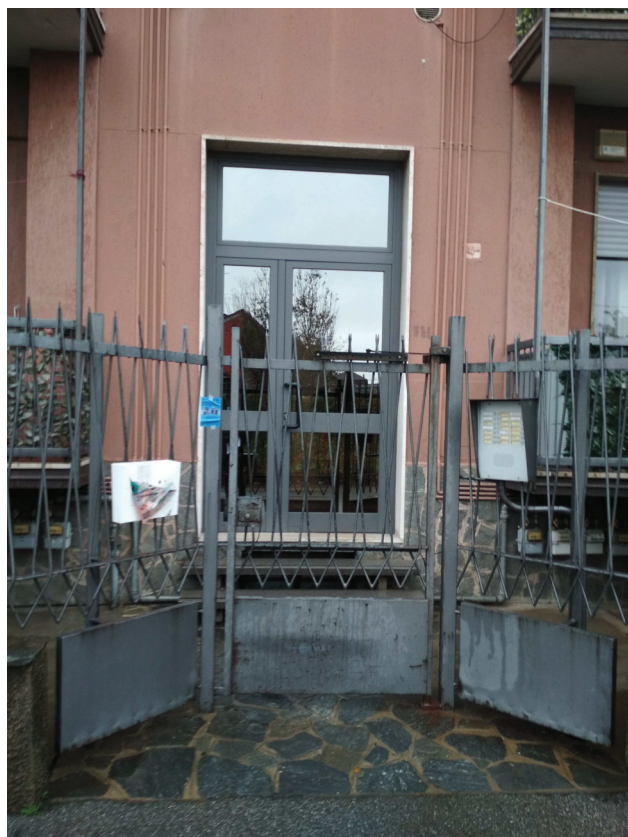
Foto n. 2 – Ingresso al fabbricato
