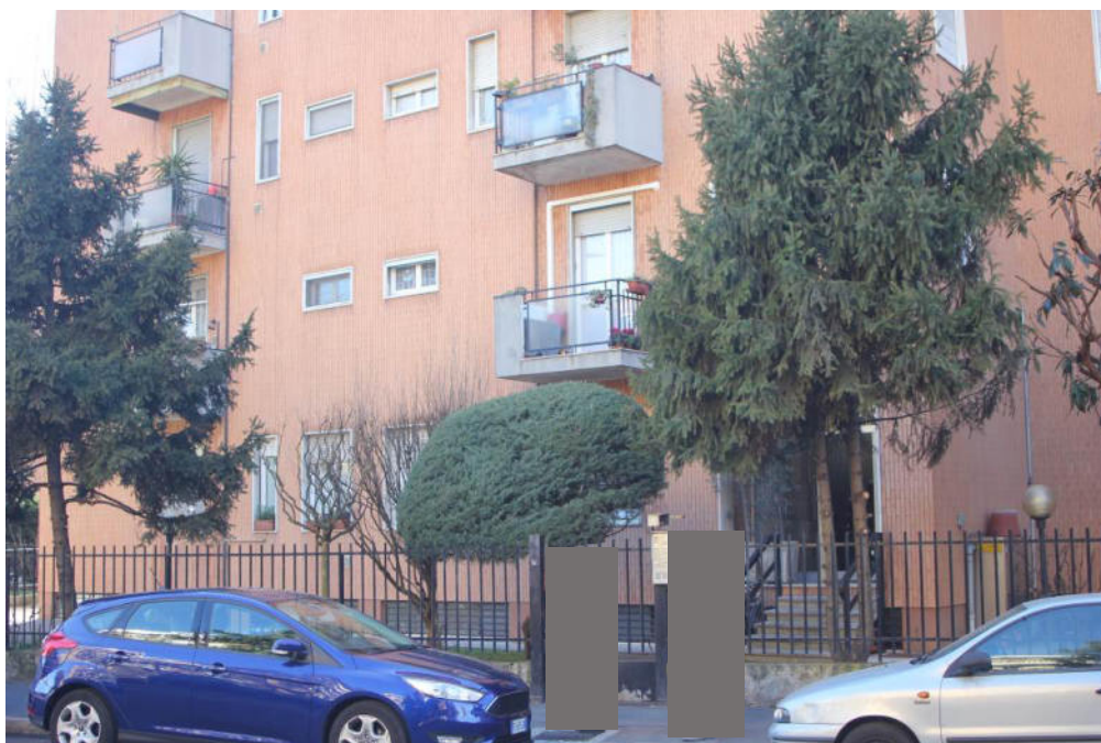
FOTO 1: MILANO, VIA CHOPIN 22, fronte edificio su via Chopin
