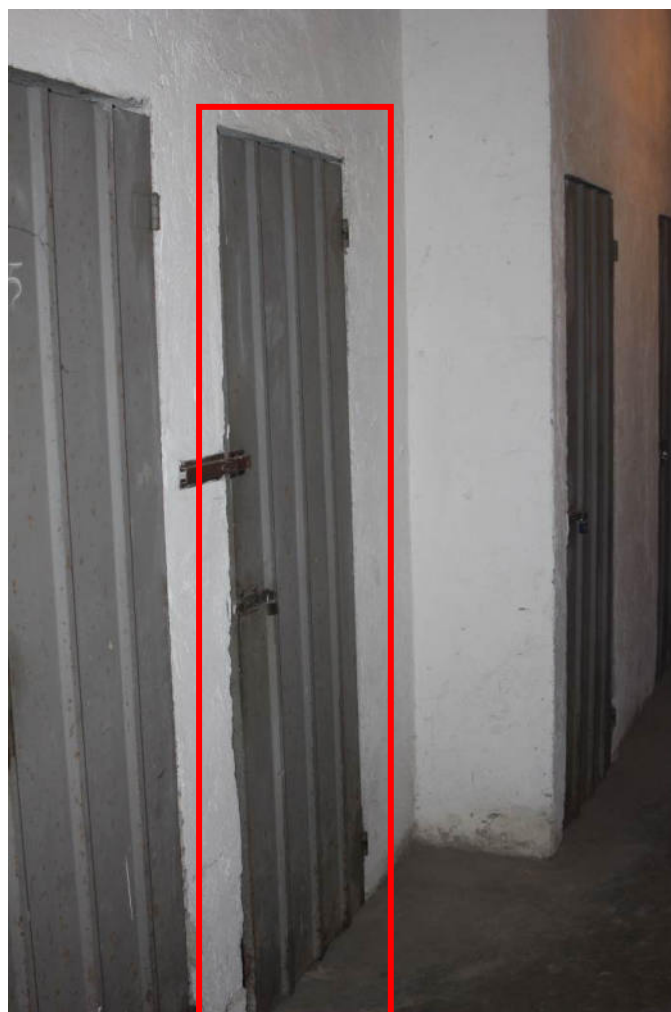
FOTO 10: MILANO, VIA CHOPIN 22, cantina
