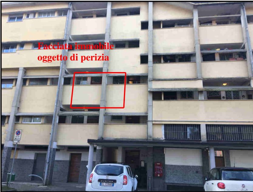
Dettaglio facciata da via Papa Giovanni XXIII
