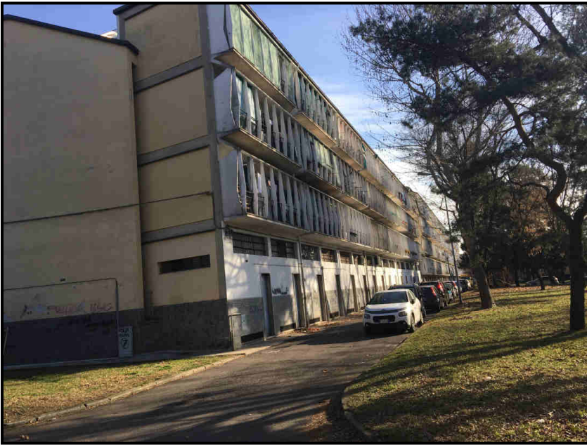
Foto da cortile interno
