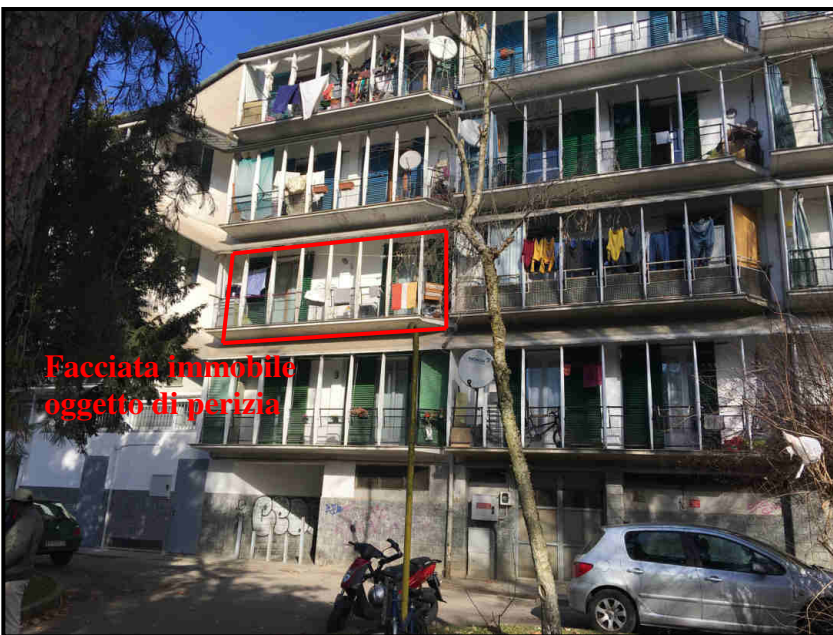
Dettaglio facciata da cortile interno
