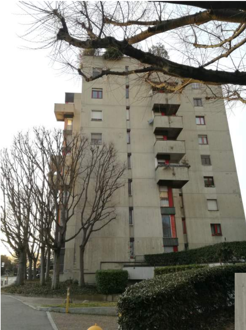
Foto 3,4 – viste esterne edificio e portoncino d'entrata
