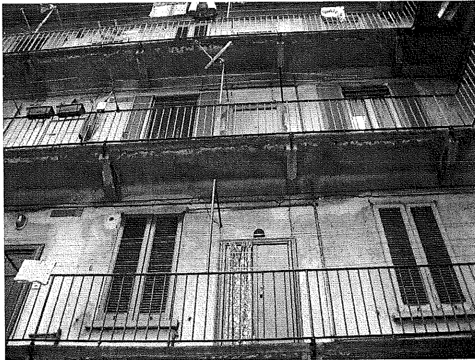
Vista della facciata dell'immobile dal cortile interno.
