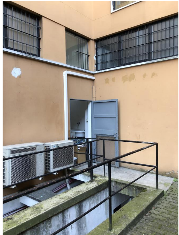
Vista bagno con accesso dal cortile P.T
