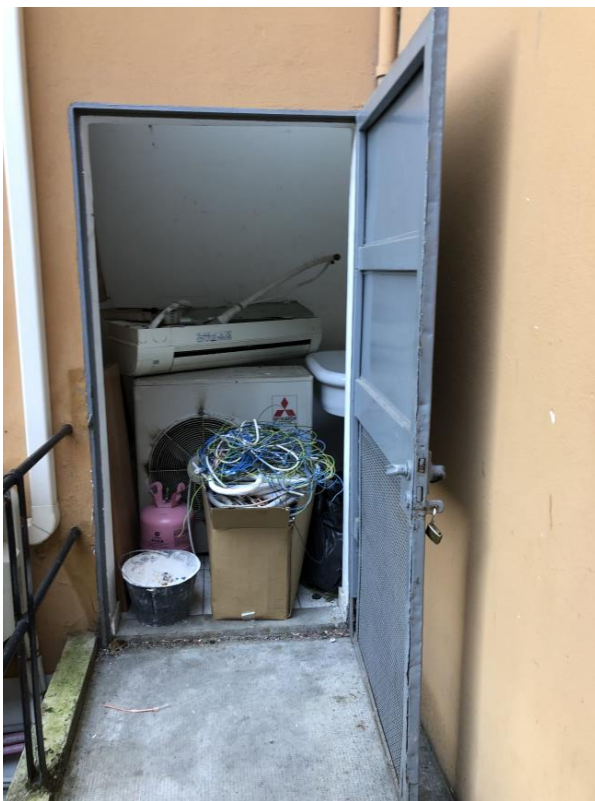
Vista bagno con accesso esterno dal cortile P.T
