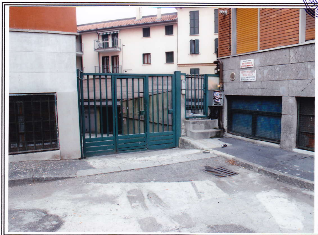
Esterno fabbricato – ingresso al cortile (ovvero percorso accesso laboratorio)
