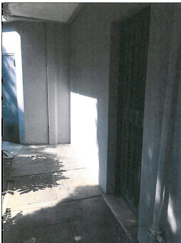
INGRESSO AI VANI CANTINA
