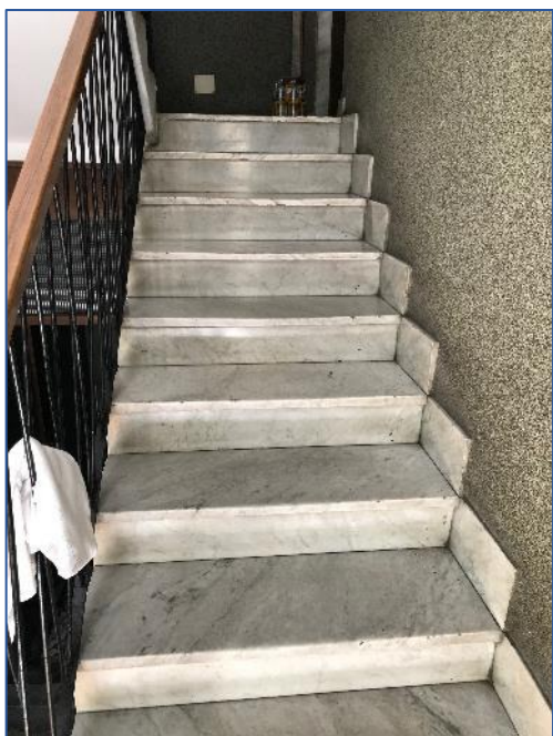
Foto 11 – vano scala comune
