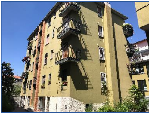
Foto 7 – fabbricato interno di via Prandina
