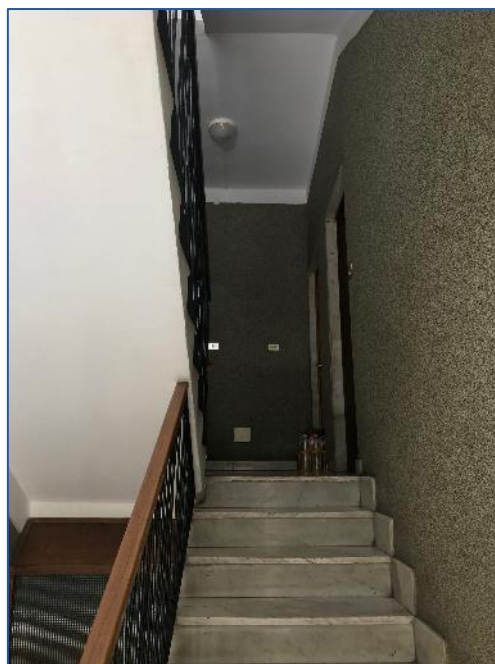
Foto 12 – vano scala comune
