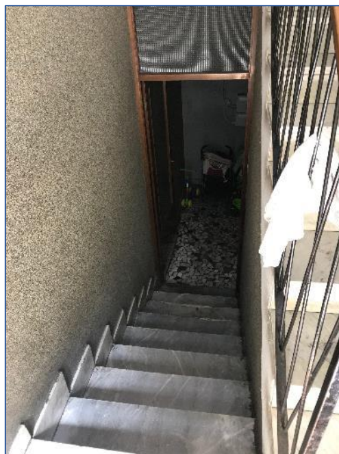
Foto 10 – vano scala comune
