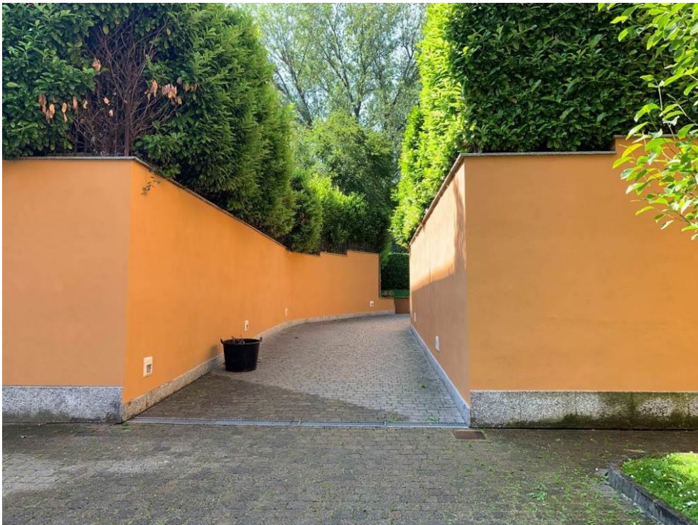
Fotografia n. 6 – Particolare della discesa che conduce alla piazzetta interna, dove è presente la palazzina (Scala C), all'interno della quale si trova l'appartamento del debitore al piano terra
