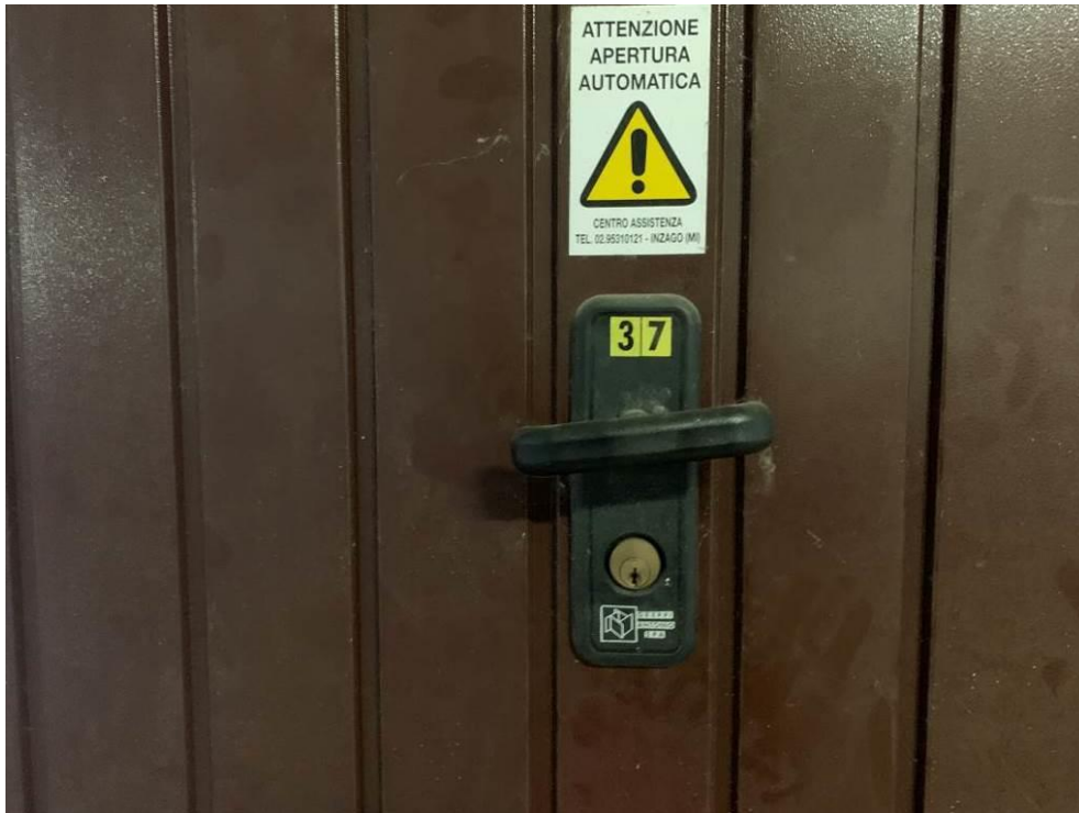
Fotografia n. 30 - Vista della saracinesca del box, contraddistinta con il numero 37, relativa all'unità immobiliare di proprietà del debitore
