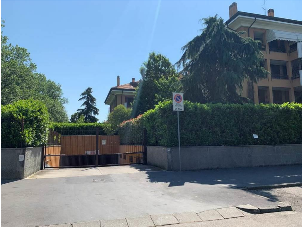
Fotografia n. 3 – Vista del prospetto principale e dell'ingresso carraio (accesso ai boxes) al Condominio Quadrifoglio 4 – Palazzina 5 su Via Caduti di Nassiriya n. 8 – Peschiera Borromeo (Mi)
