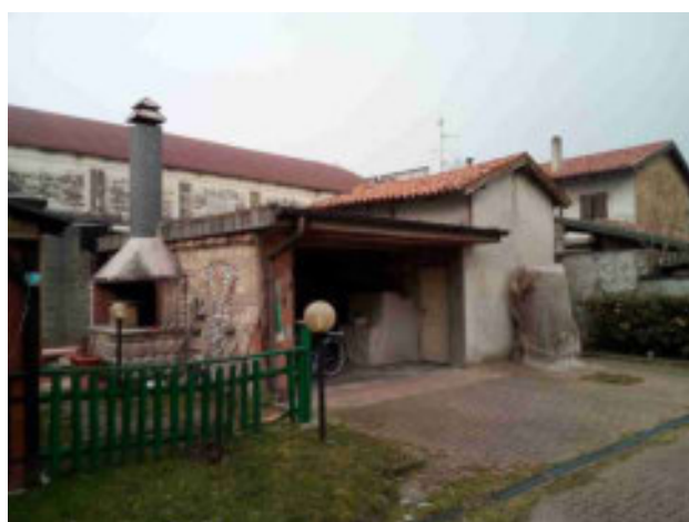
Veduta esterna edificio accessorio
