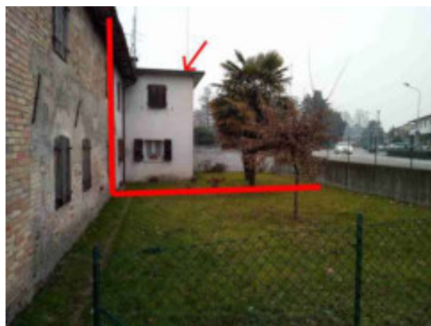
Veduta esterna edificio residenziale da via Marango
