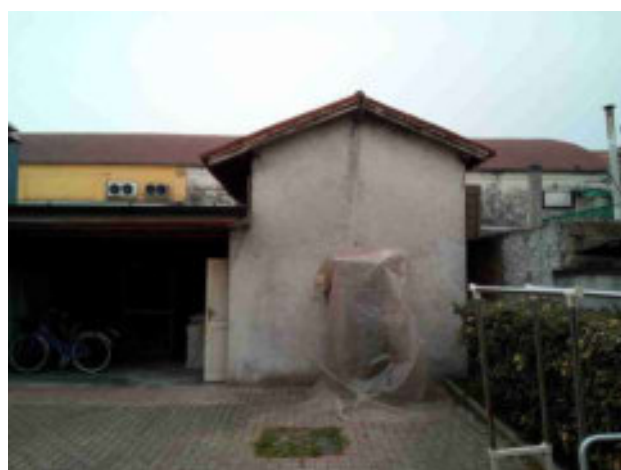
Veduta esterna edificio accessorio
