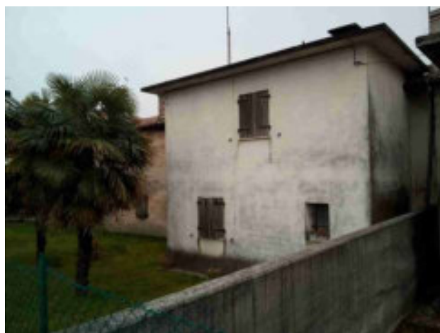
Veduta esterna edificio residenziale da via Marango
