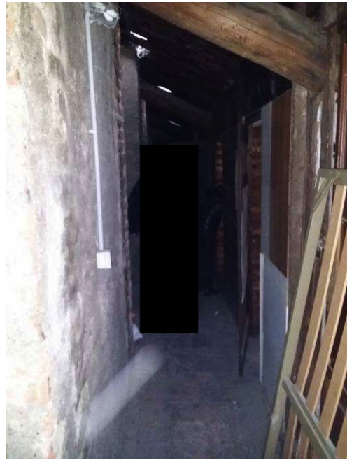
Foto 18 - disimpegno comune piano 5°
