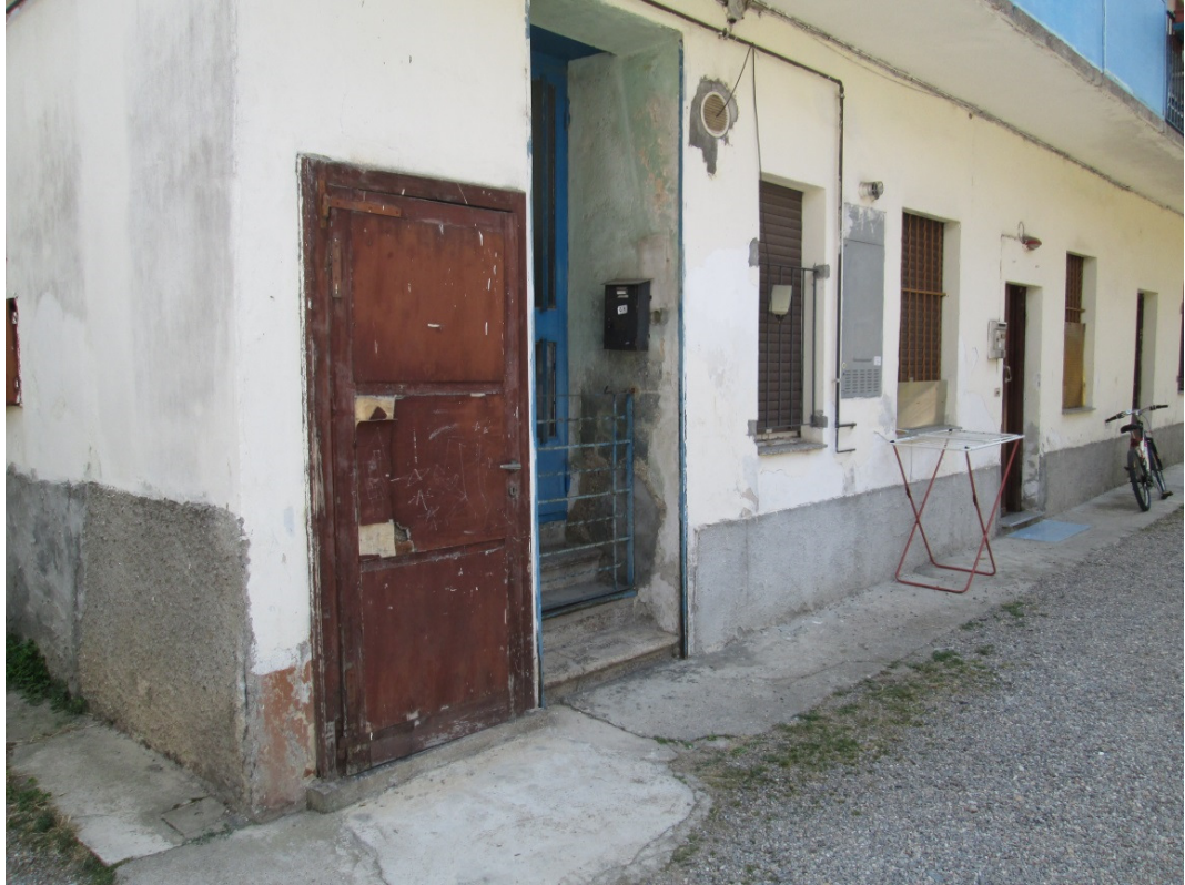
Facciata unità immobiliare e ingresso ripostiglio
