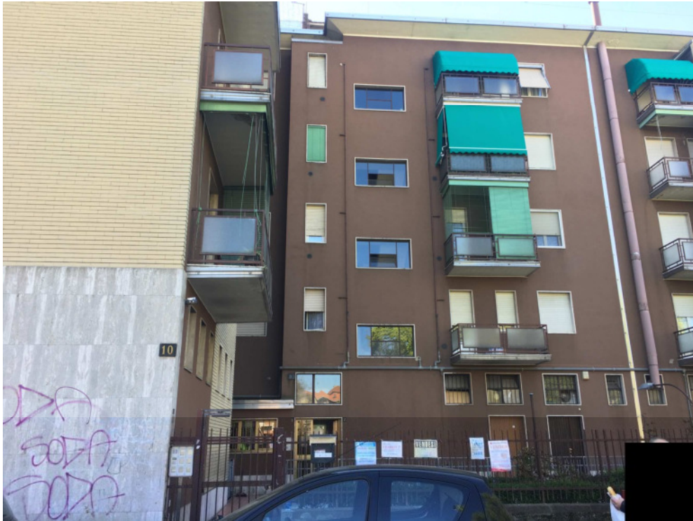
FOTO 1: MILANO, VIA PRIVATA MARIA MELATO 10, facciata edificio
