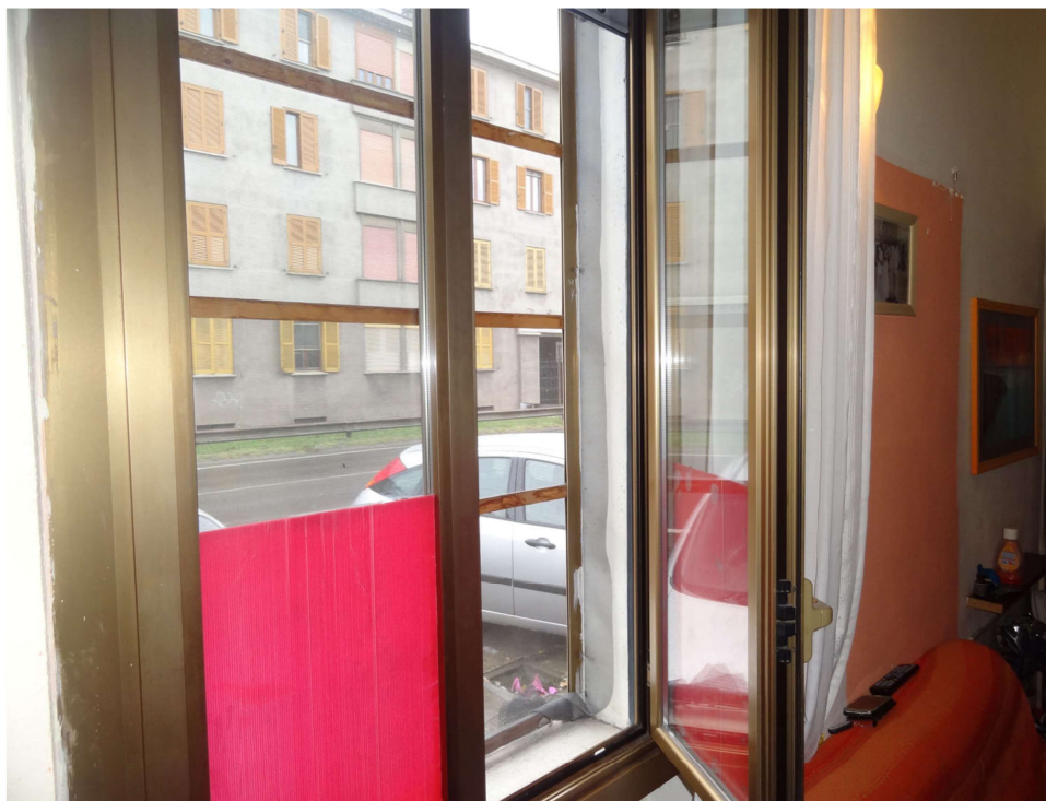
Foto interna – dettaglio serramento interno
