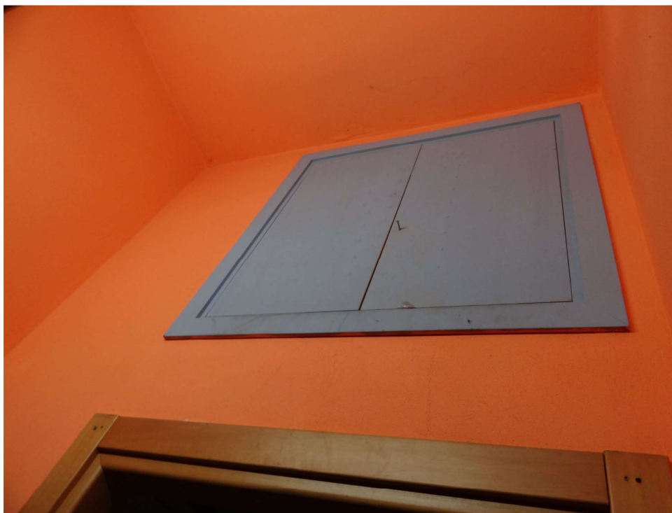
Foto interna – ripostiglio in quota
