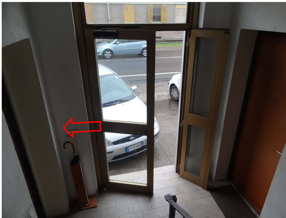
Foto interna - ingresso principale condominio lato interno
