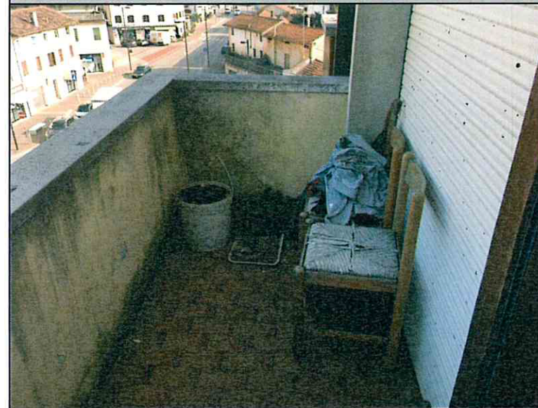
Vista dello stato manutentivo della terrazza
