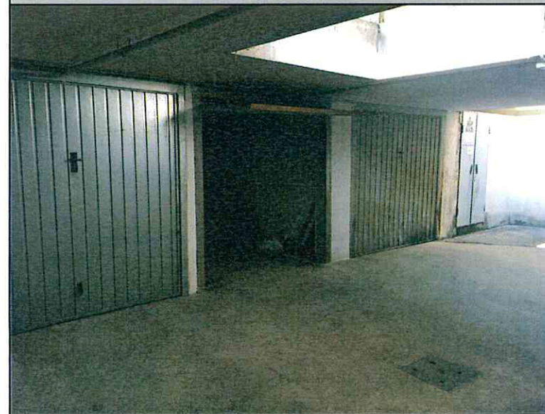
Vista esterna del garage ad uso deposito
