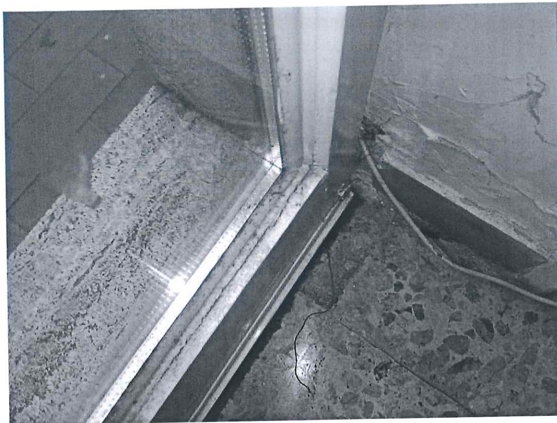
Dettaglio sostituzione vetro
