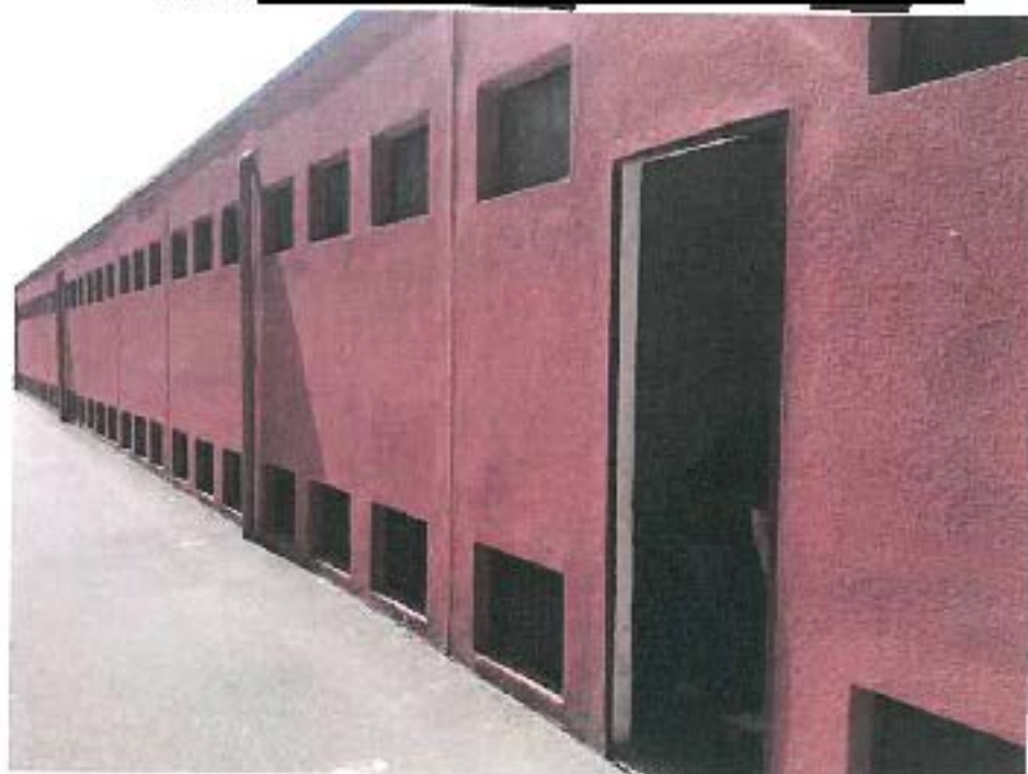
Esterno cantine _ Foto n. 15
