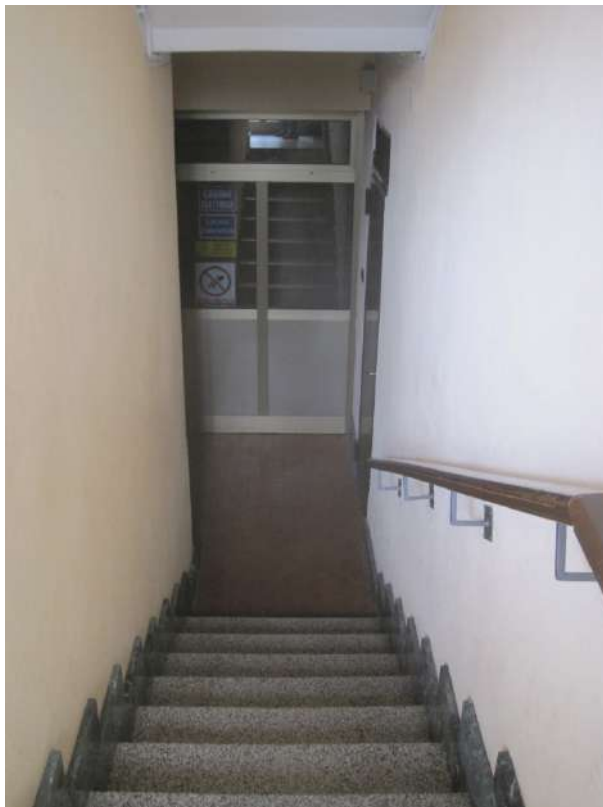
Scala di accesso al piano seminterrato
