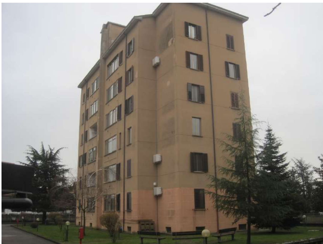
Fronti Est e Nord dell'edificio
