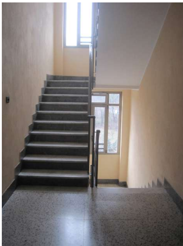
Vano-scala al piano quarto
