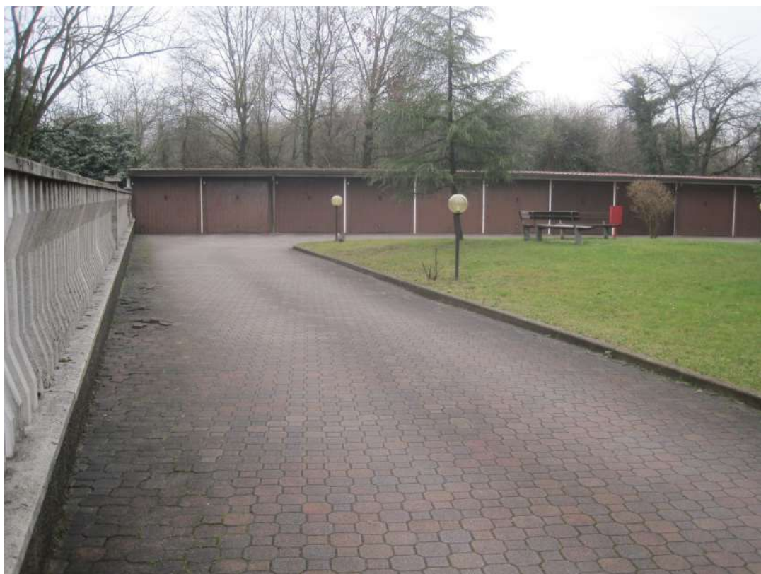
Corsello di manovra dell'autorimessa condominiale a Ovest
