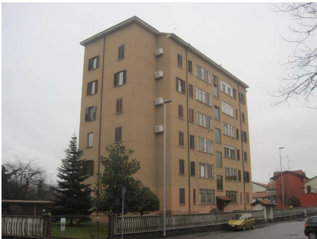
Fronti Ovest e Sud dell'edificio
