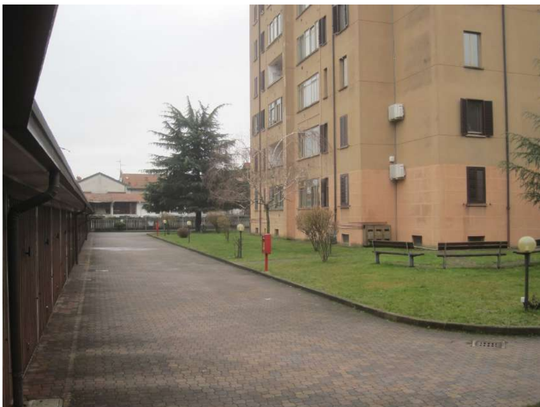
Corsello di manovra dell'autorimessa condominiale a Nord
