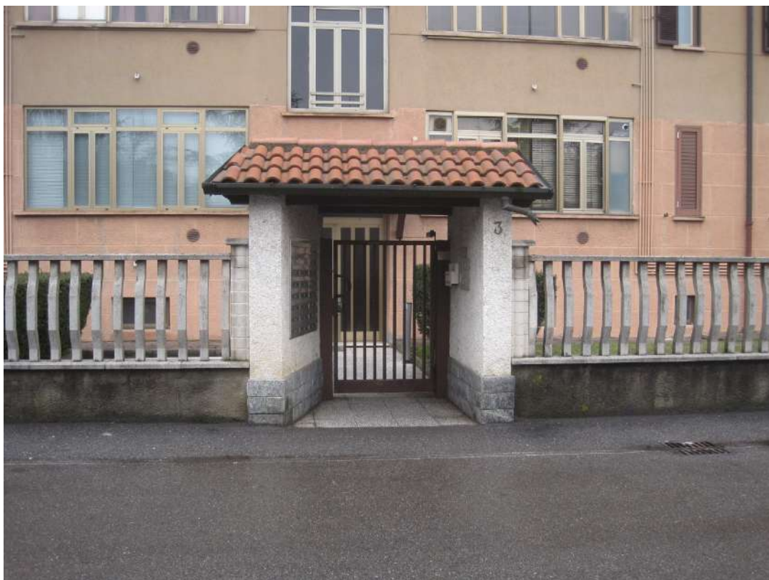
Cancello pedonale a Sud
