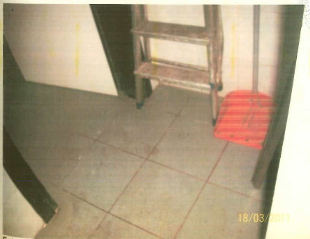
Foto n.: 24 – disimpegno dei gabinetti a servizio della ex cucina –
