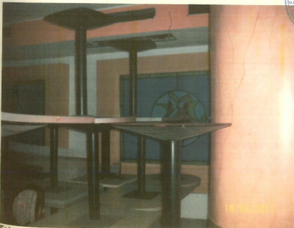
Foto n.: 4 – Vista interna del locale Sub 501, (zona ex bar) –
