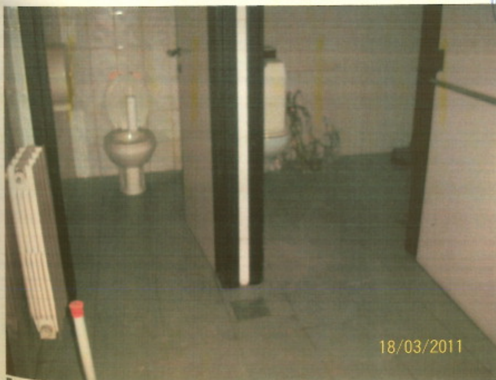
Foto n.: 10 – Gabinetto al piano del locale Sub 501 (ex bar) –
