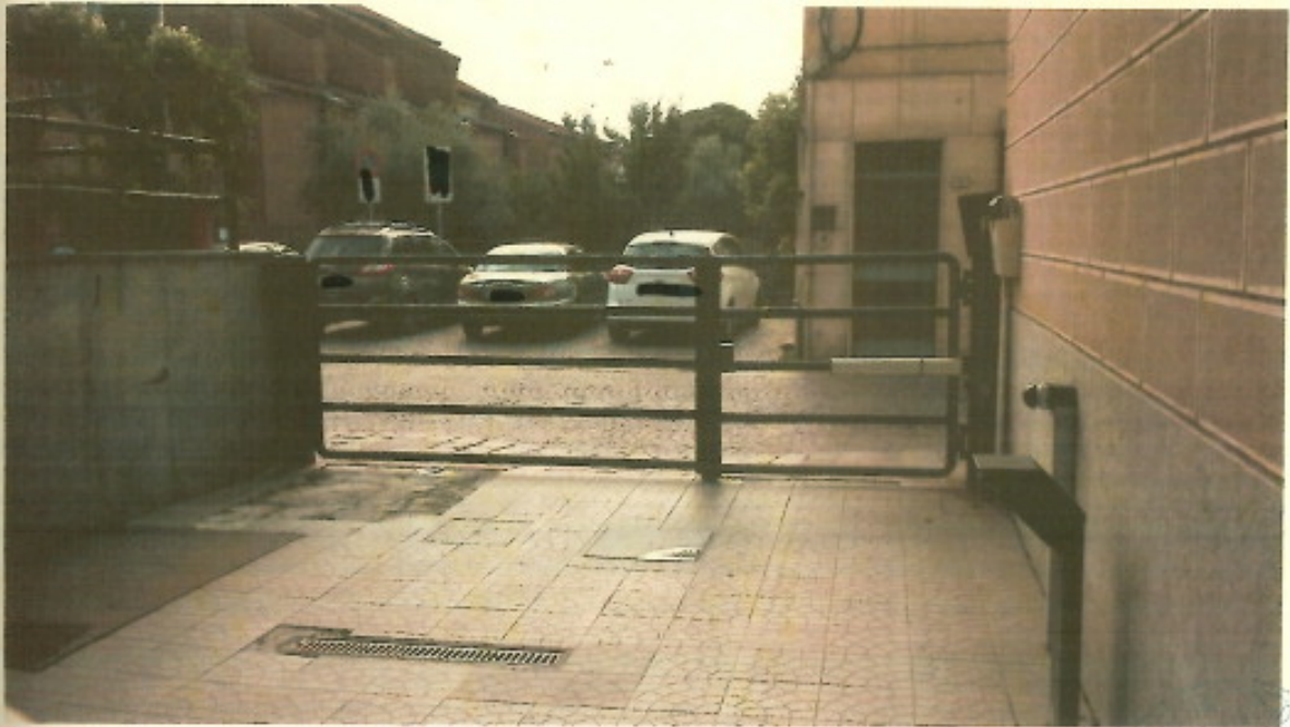
Foto n.: 27 – Cannello carraio per e dai box; per e dalle cantine –
