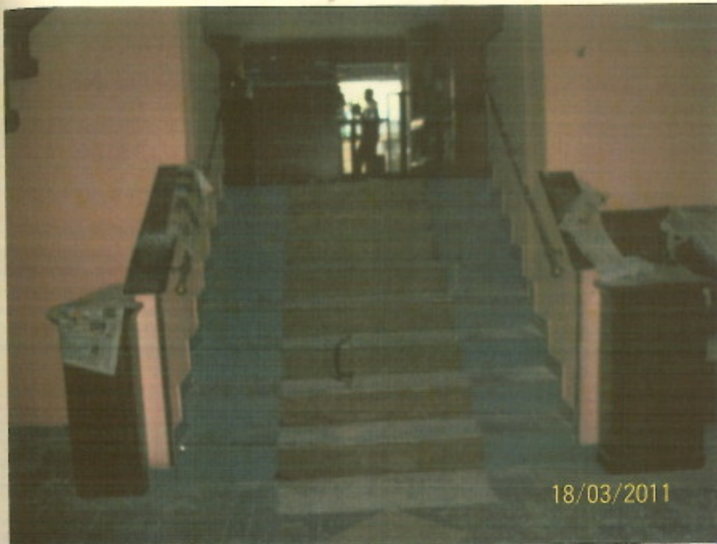
Foto n.: 13 – La scala di comunicazione tra locale zona ex bar e zona ex ristorante
