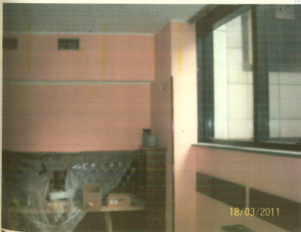
Foto n.: 16 – Vista di un angolo del locale Sub 508, ex ristorante –
