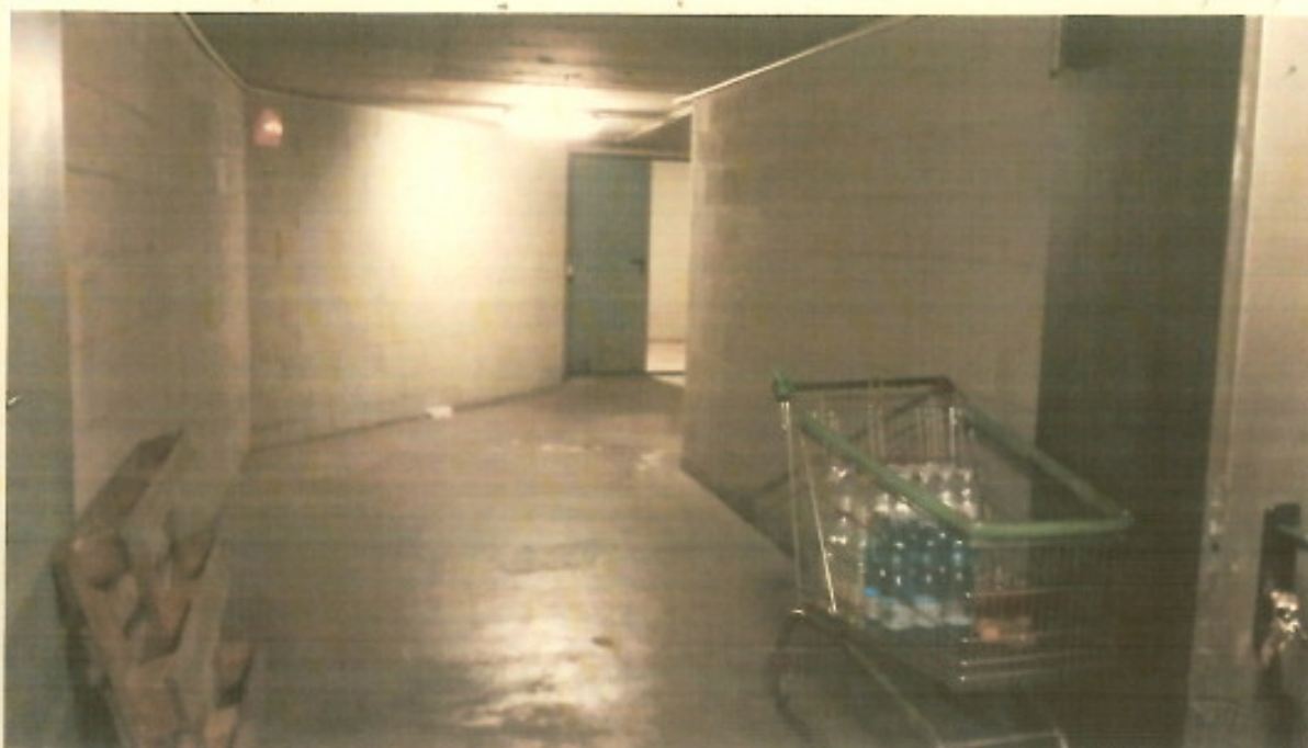
Foto n.: 33 – Corridoio comune – corsello entrata / uscita –
