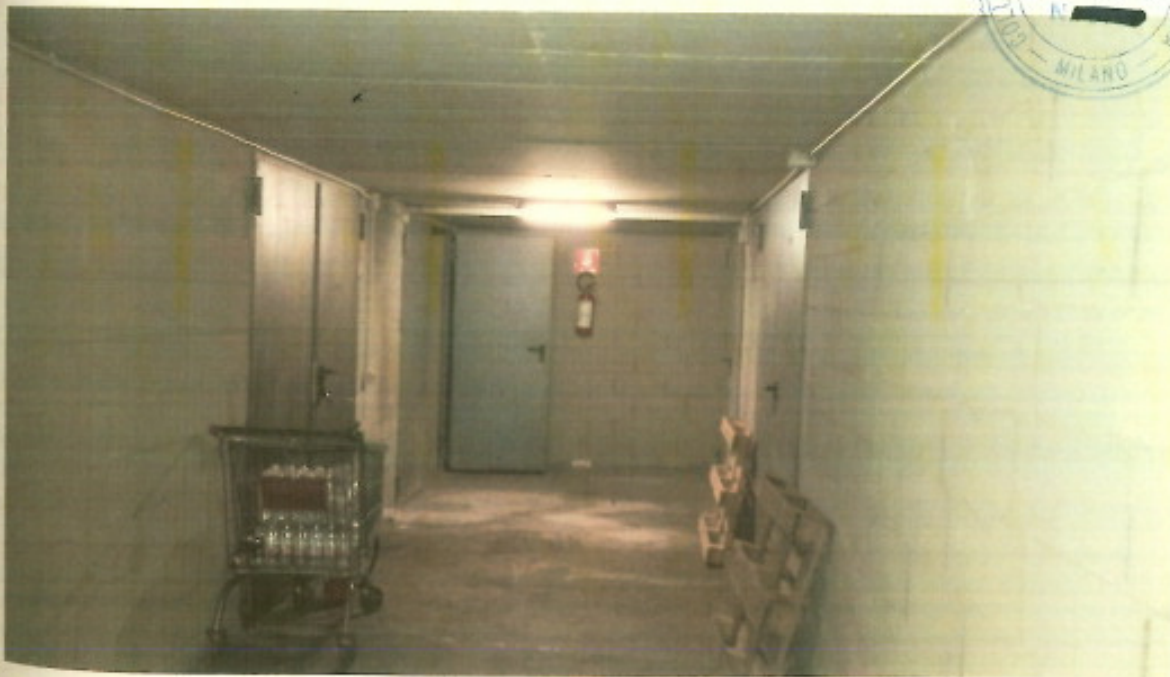
Foto n.: 30 – corridoio al secondo interrato per e dai magazzini –
