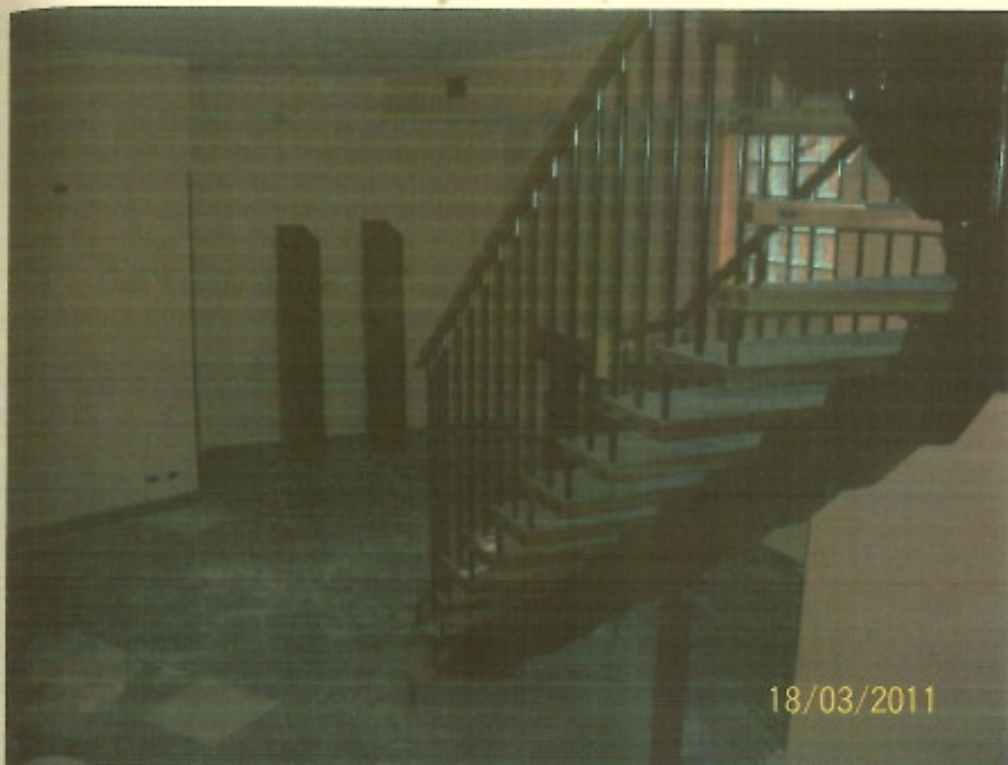
Foto n.: 15 – La scala di accesso al primo piano dal locale Sub 508 - ex ristorante –
