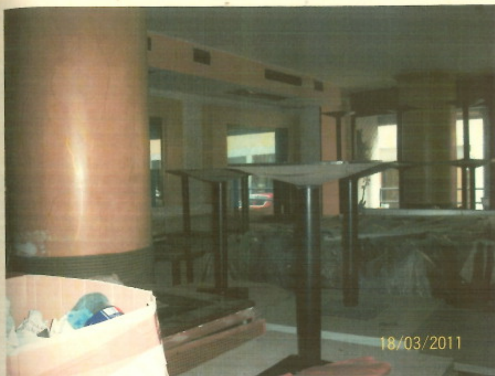
Foto n.: 9 – Vista interna del locale Sub 501, (zona ex bar - altra vista) –
