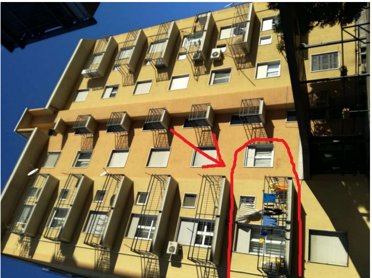
Edificio visto da cortile interno, in evidenza appartamento.
