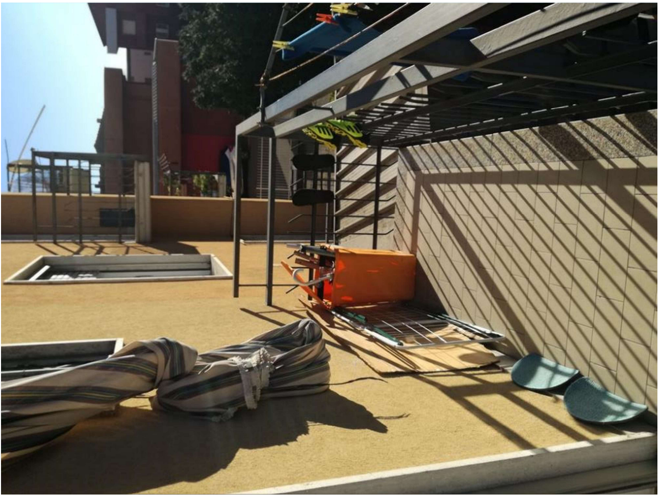
Balcone su cortile interno
