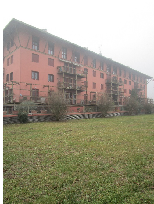
Edificio prospetto (nord ovest)
