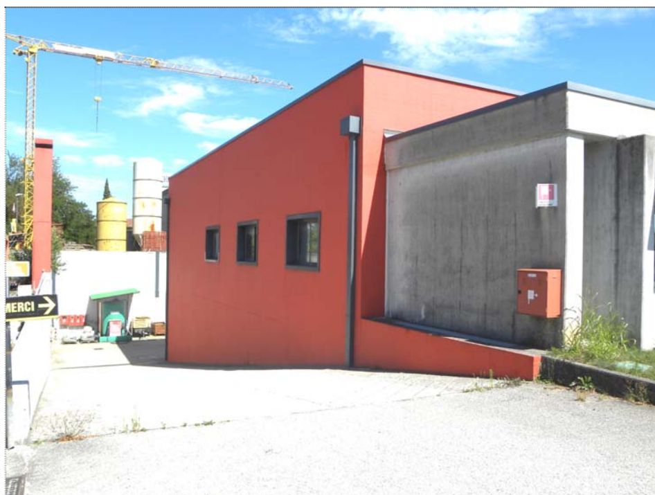
Compendio aziendale - Pordenone, via Roveredo 52/C: rampa accesso all'interrato
