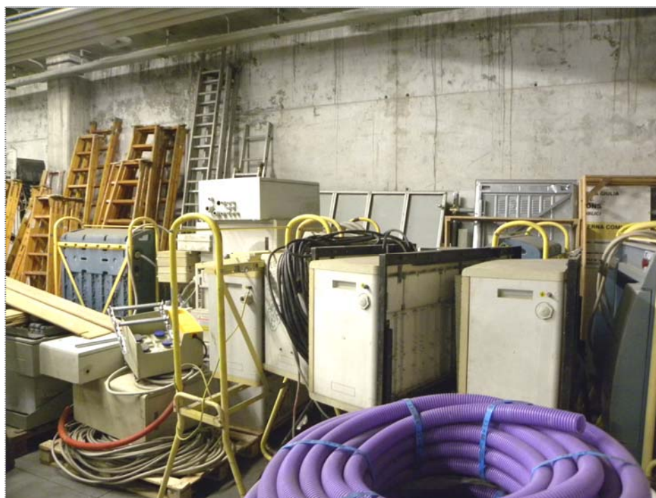
macchinari e attrezzature varie (interrato.2)
