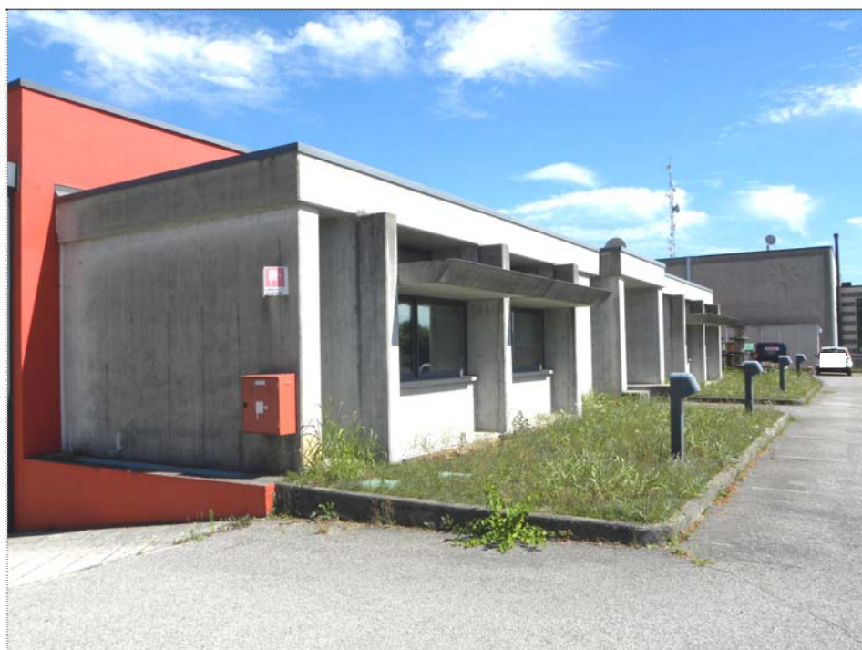
Compendio aziendale - Pordenone, via Roveredo 52/C: particolare fronte uffici
