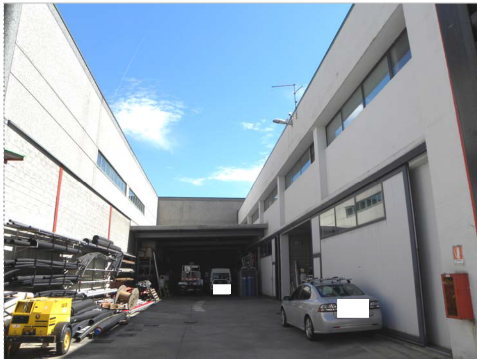
Compendio aziendale - Pordenone, via Roveredo 52/C: retro a piano interrato (Est)
