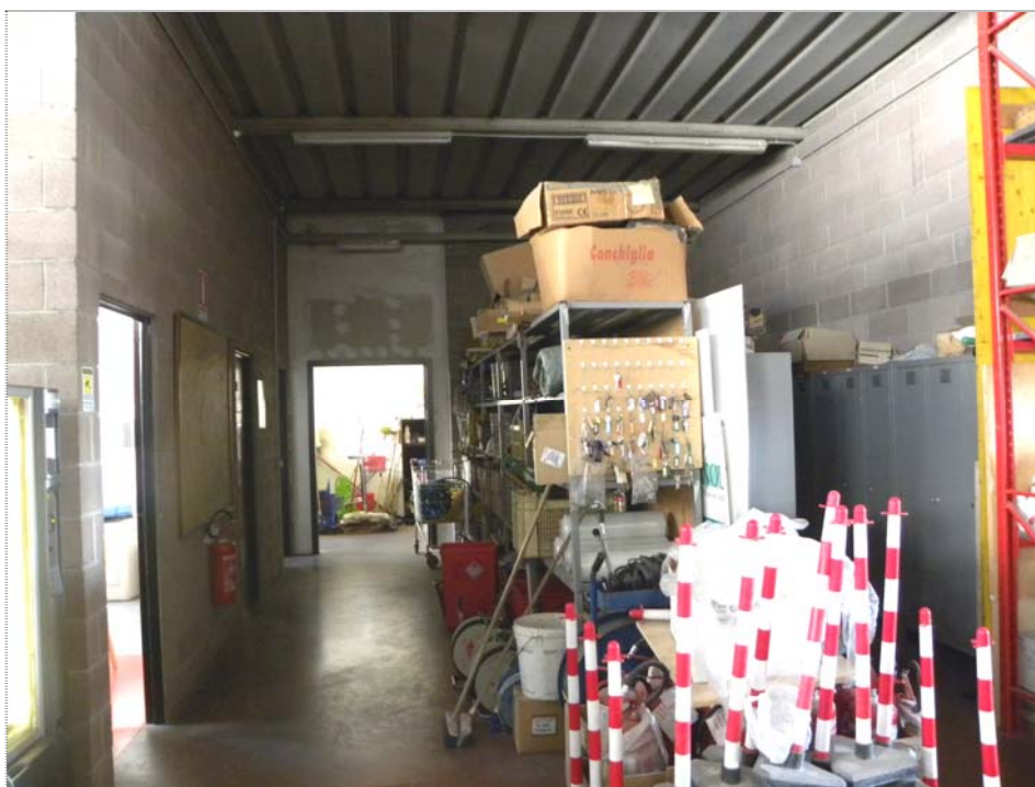
Compendio aziendale - Pordenone, via Roveredo 52/C: interno zona servizi/mensa (piano terra)
