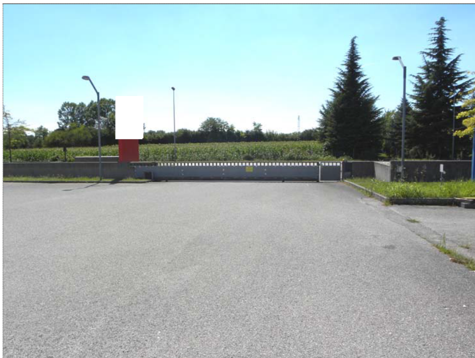
Compendio aziendale - Pordenone, via Roveredo 52/C: piazzale ingresso
