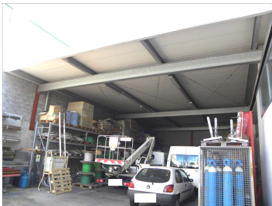
Compendio aziendale - Pordenone, via Roveredo 52/C: tettoia (piano interrato)
