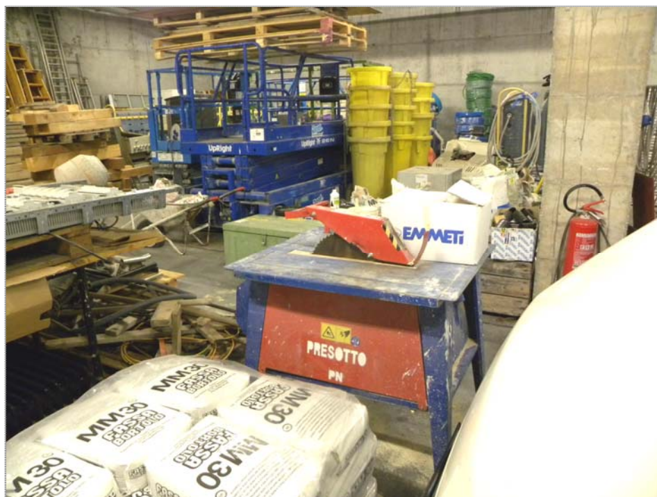
macchinari e attrezzature varie (interrato.2)
