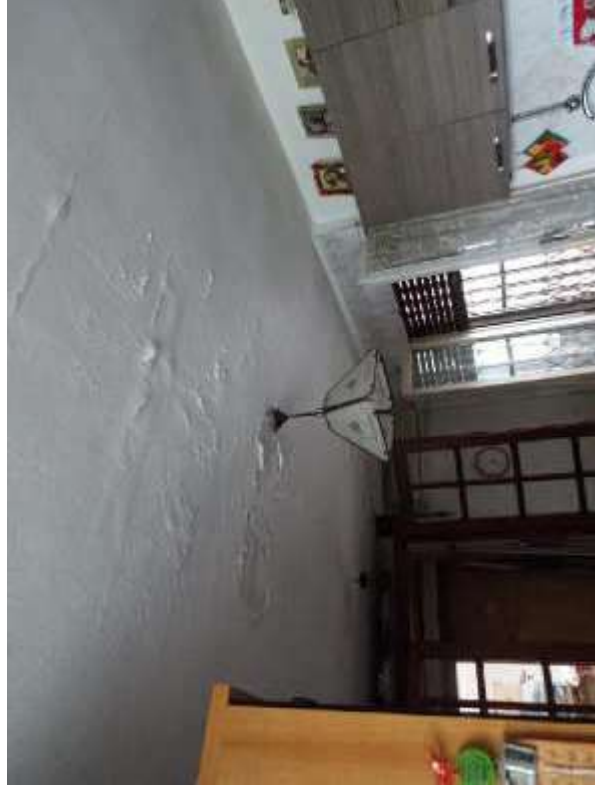
piano T appartamento lotto B soggiorno tracce infiltrazioni plafone
