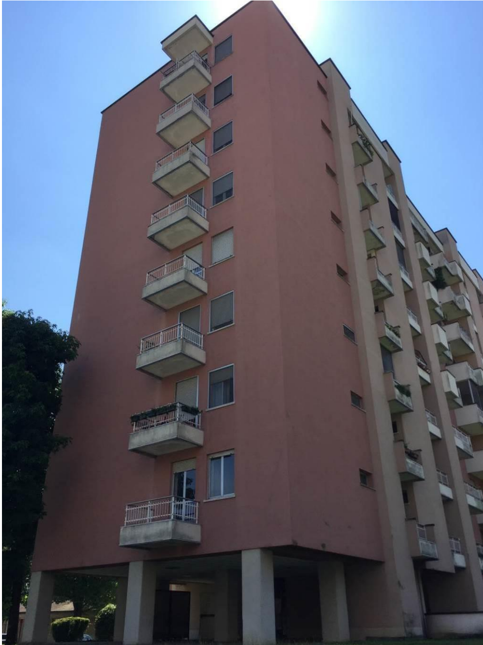
Fotografia n. 3 – Vista dei prospetti laterale e secondario della palazzina con gli accessi al civico n. 41 e n. 43 di Via Sporting Mirasole – Opera (Mi) Loc. Noverasco dove, al piano sesto, sono visibili il balcone (lato est) e la loggia (lato nord) dell'appartamento oggetto della procedura
