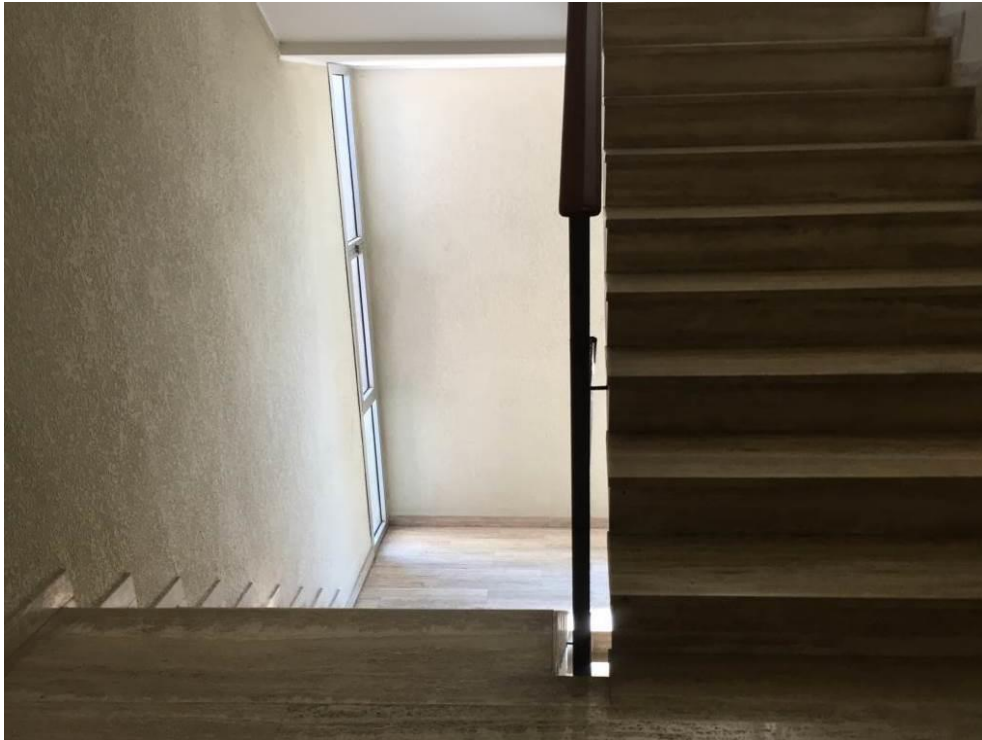
Fotografia n. 12 – Vista del corpo scale
