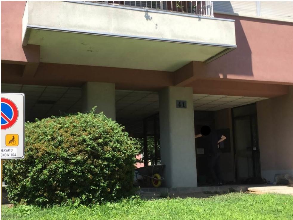
Fotografia n. 8 – Vista dell'ingresso al civico n. 41, dove si trovano l'appartamento (piano sesto)
