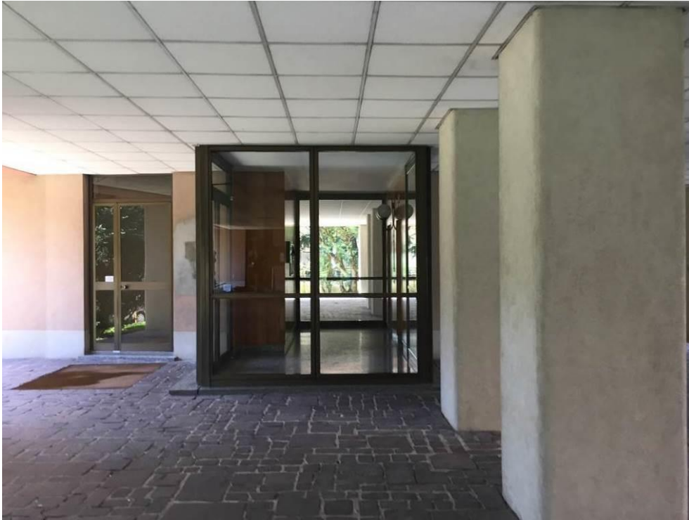
Fotografia n. 4 – Vista dall'esterno dell'atrio di accesso al civico n. 43, dove al piano interrato è localizzato il posto auto oggetto della procedura, accessibile solo dall'esterno del corpo scale
