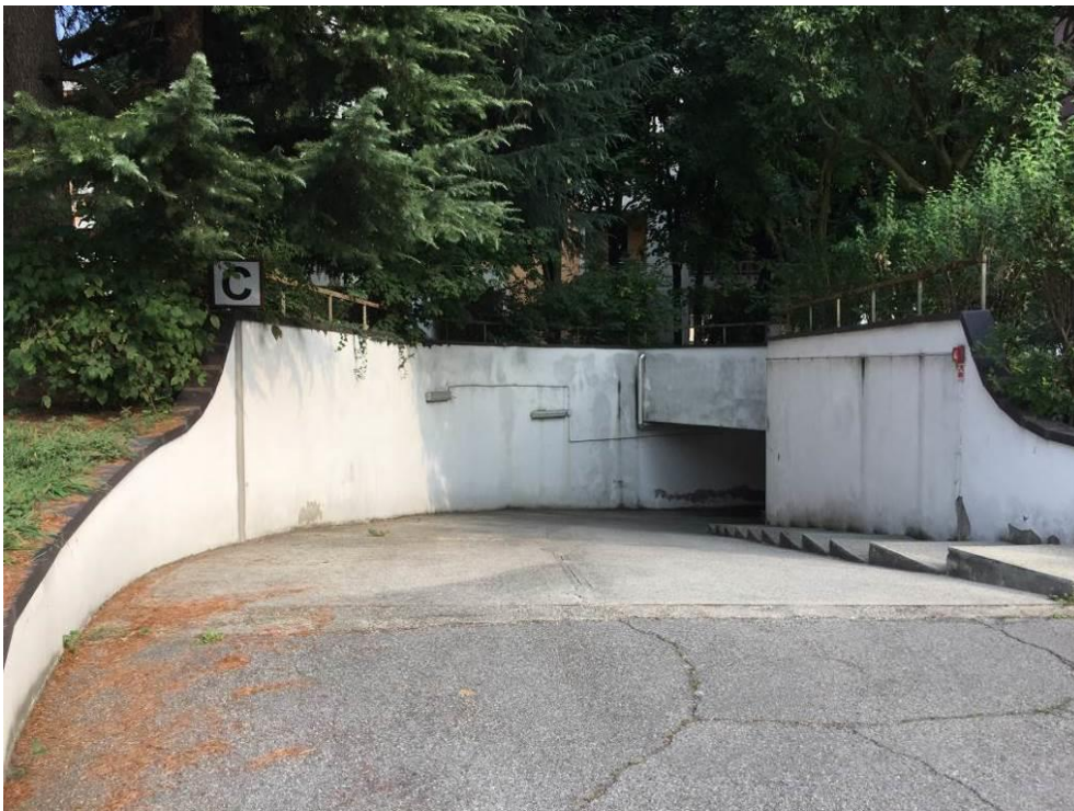
Fotografia n. 5 – Vista della rampa di accesso al piano interrato, dove si trova il posto auto oggetto della procedura
