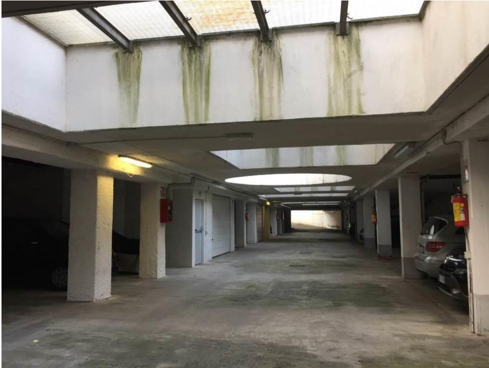
Fotografia n. 6 – Vista del corsello del piano interrato, dove si trova il posto auto oggetto della procedura
