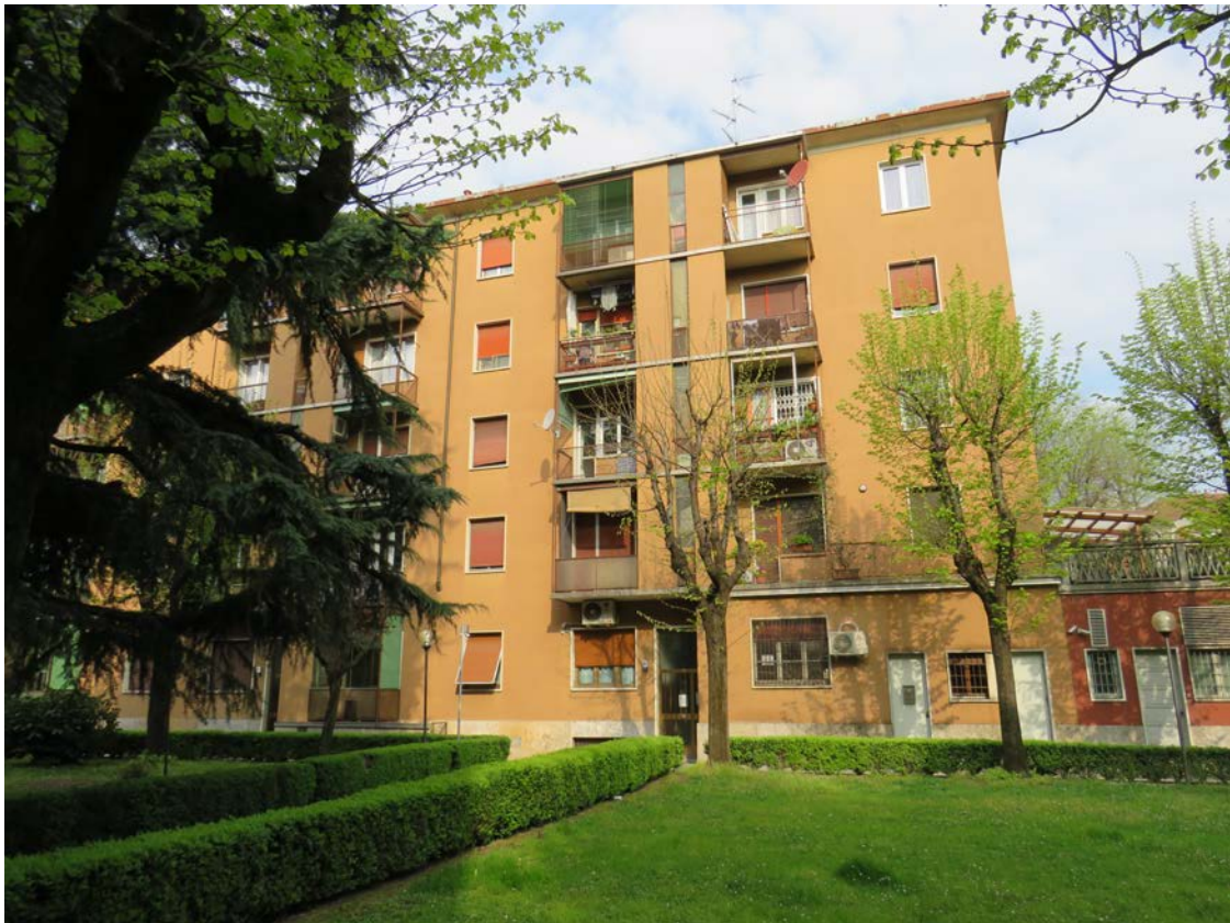
FACCIATA SU GIARDINO INTERNO
