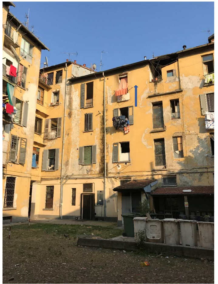
Facciata su cortile con indicazione finestra appartamento
