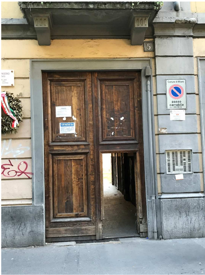
Accesso da Viale Torelli
