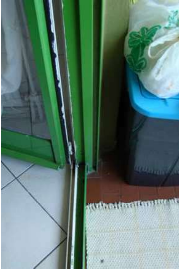
21. Dettaglio del serramento.
