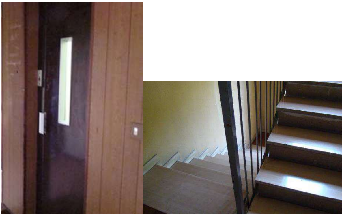
6. Dettaglio dell'ascensore e delle scale condominiali.
