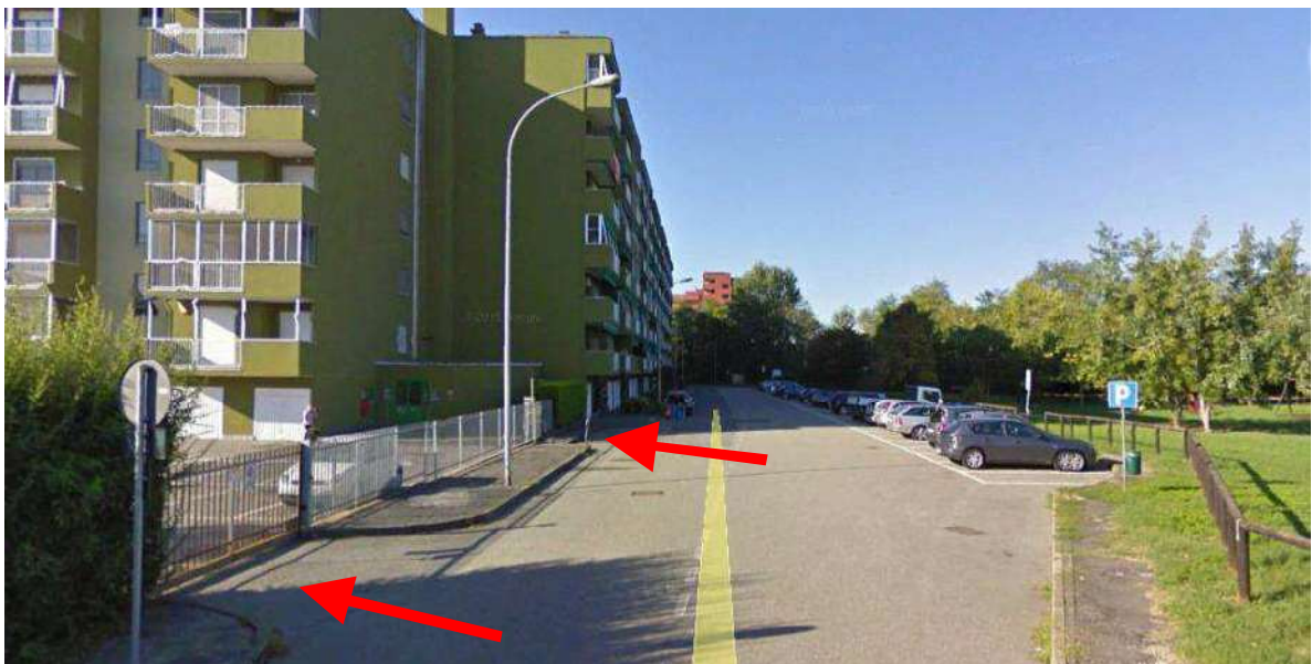
4. Rilievo fotografico del contesto. Vista su via Brodolini: indicazione dell'ingresso carrabile e pedonale.
