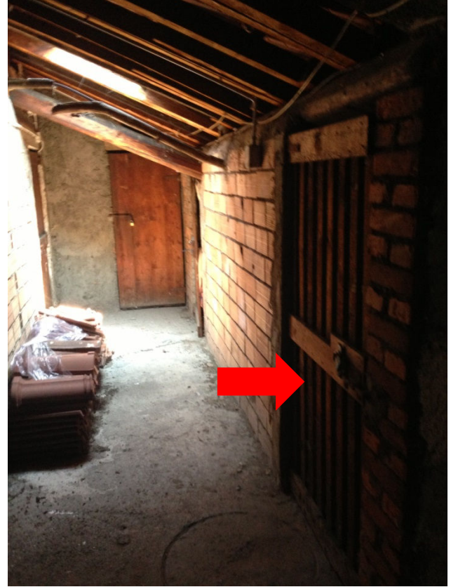
Vista porta solaio di pertinenza
