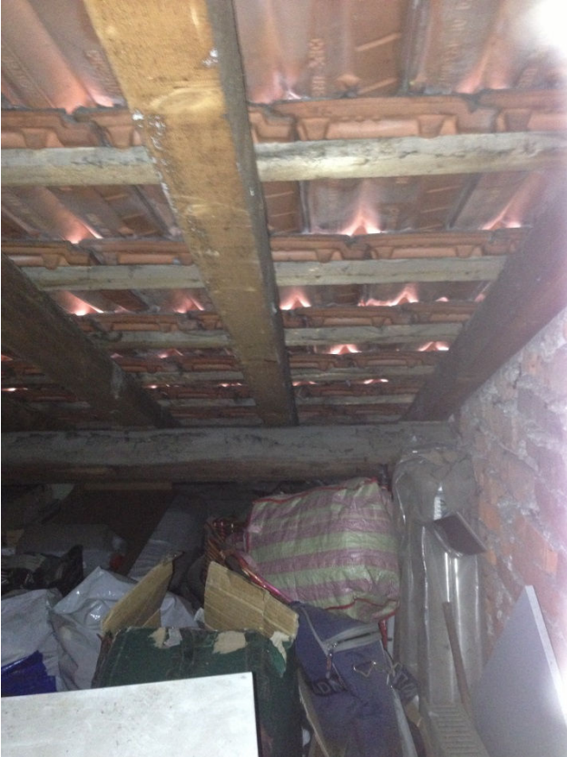
Vista solaio di pertinenza
