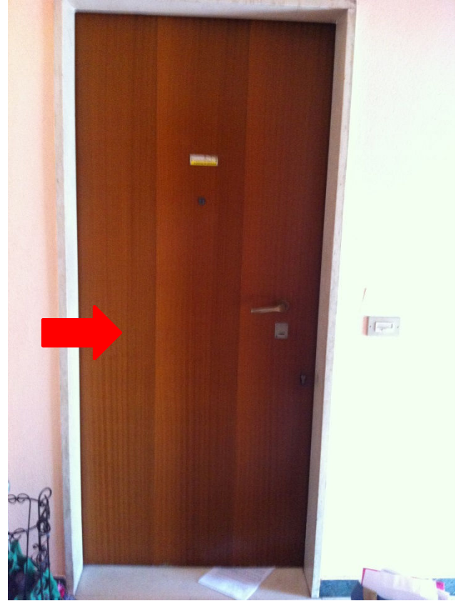
Vista porta ingresso
