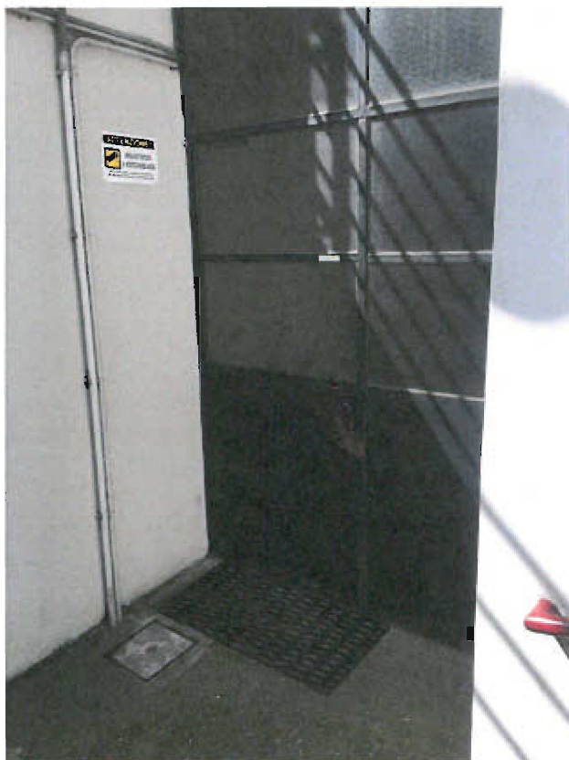
INGRESSO PIANO INTERRATO CANTINE
