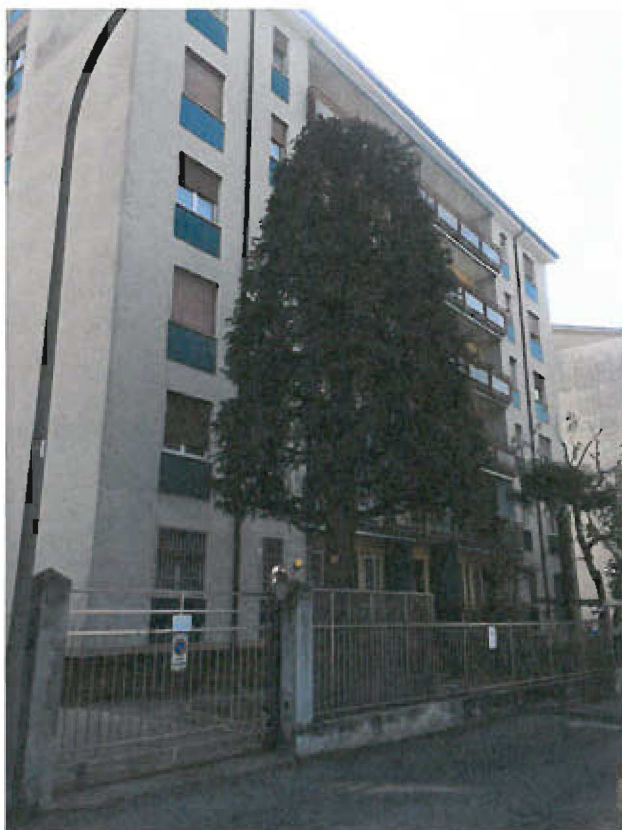
PROSPETTO OVEST FABBRICATO
