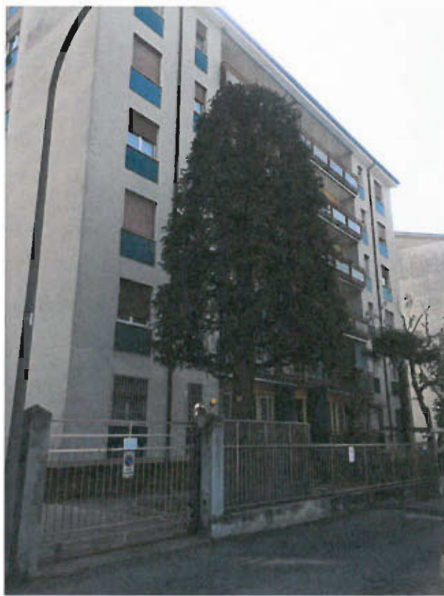
PROSPETTO OVEST FABBRICATO
