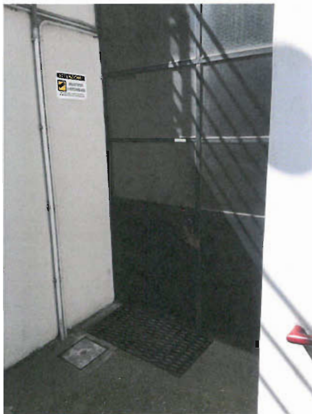
INGRESSO PIANO INTERRATO CANTINE
