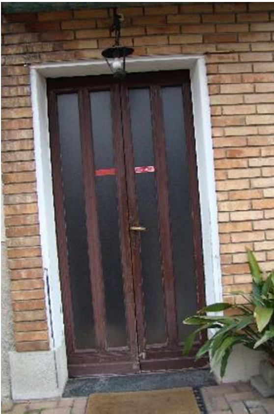
4. Dettaglio del portone di accesso alla scala.
