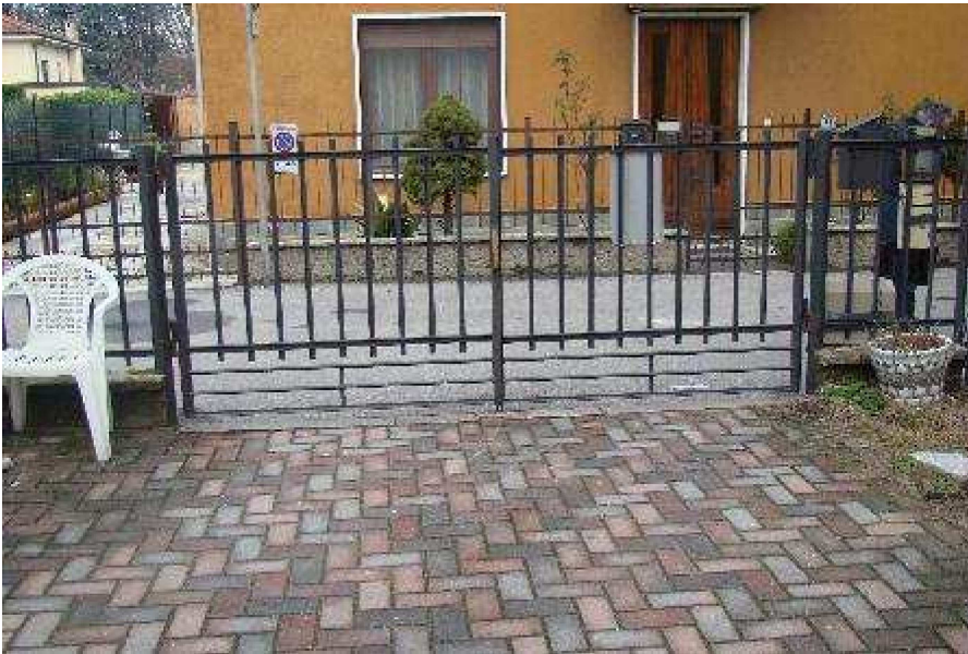
3. Dettaglio dell'ingresso carrabile.
