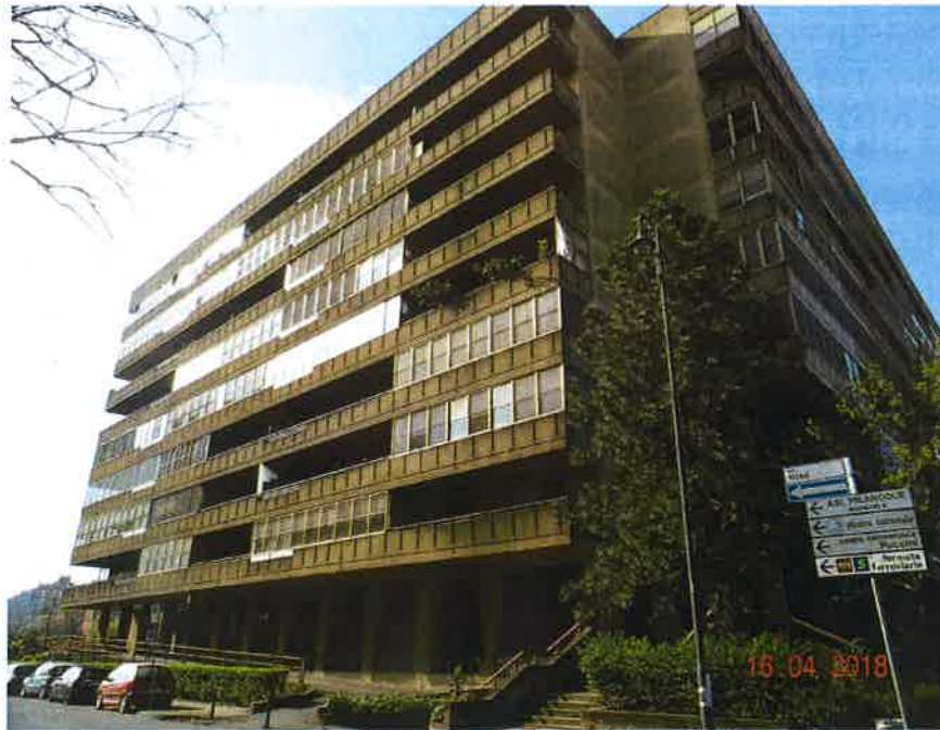
Vista esterna - ingresso pedonale fronte strada
