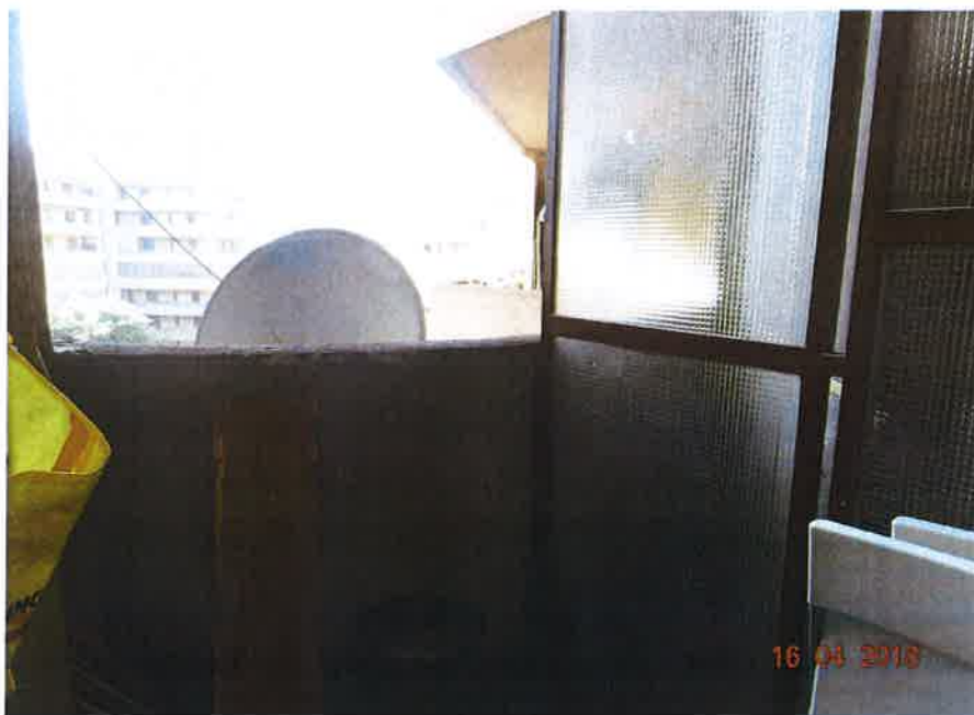
Vista esterna - balcone lato cucina
