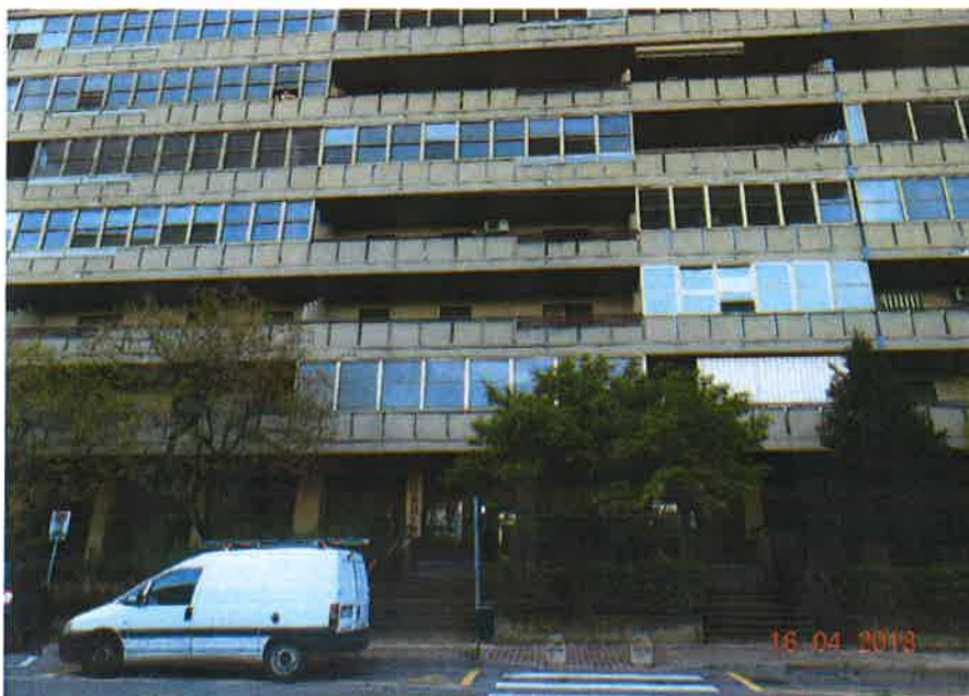
Vista esterna - dettaglio - ingresso pedonale fronte strada
