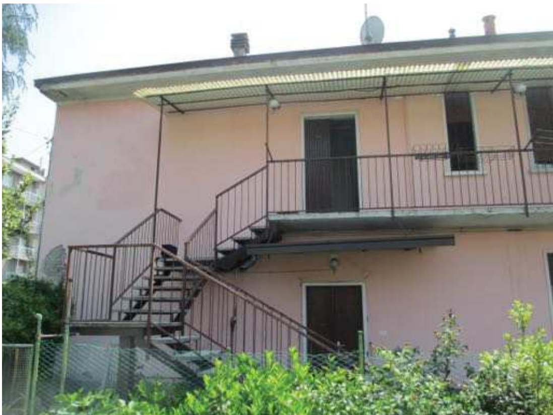
Scala esterna e ballatoio comune dal cortile
