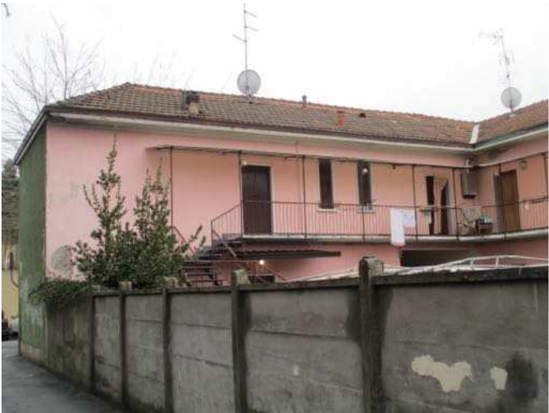
Vista dell'edificio da Via Monte Ceneri
