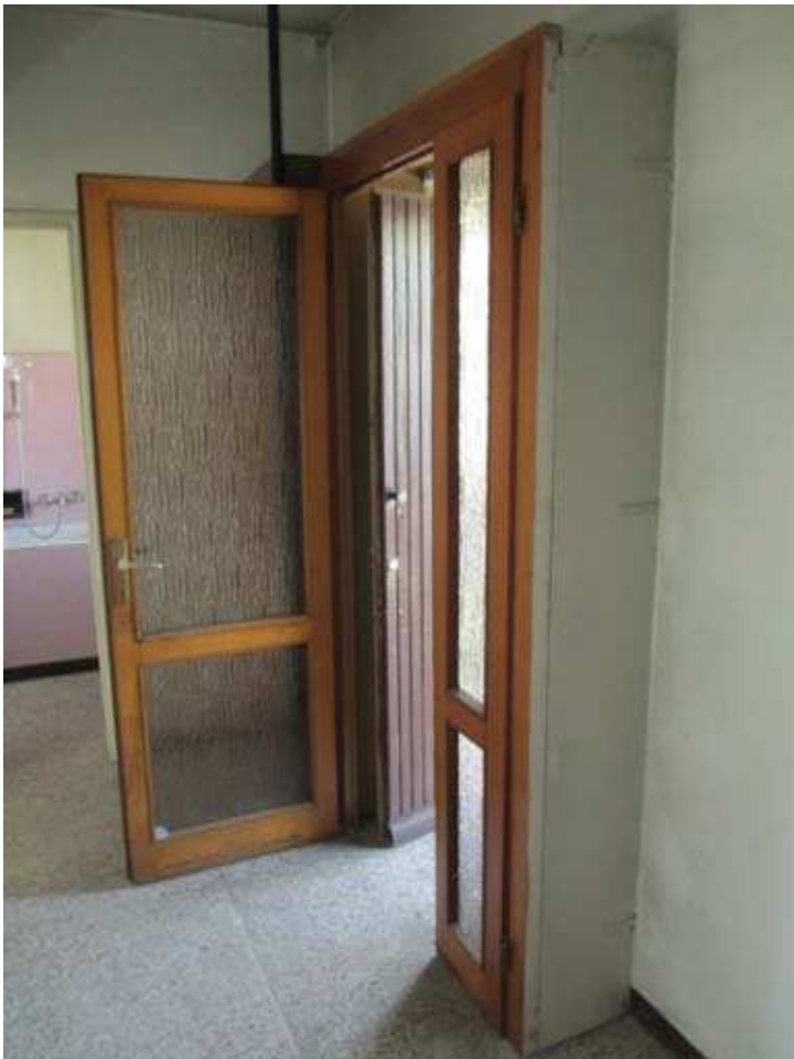
Ingresso all'unità immobiliare
