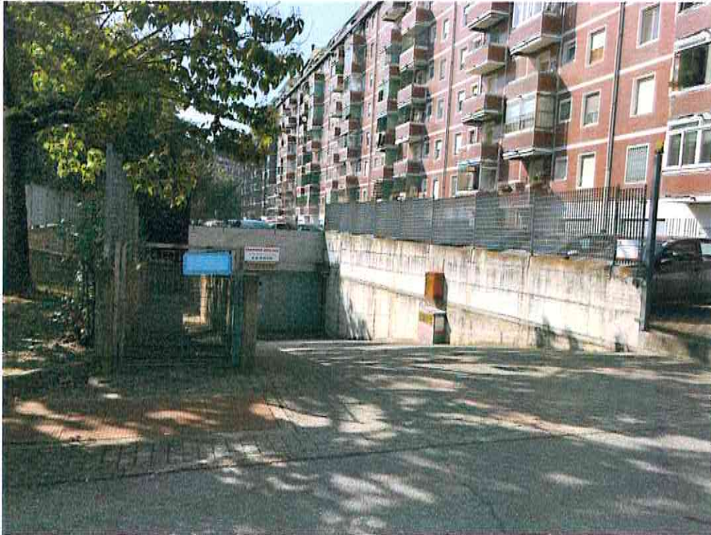
Vista accesso al fabbricato boxes da Via De Pretis
