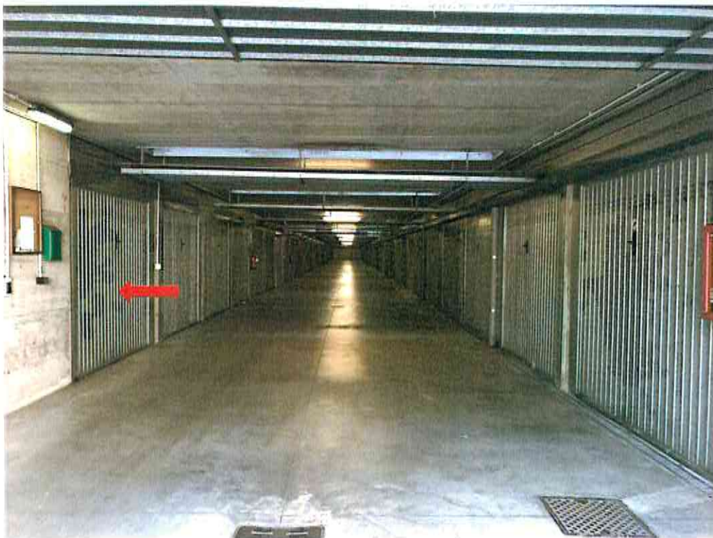
Vista corsello comune ai boxes
