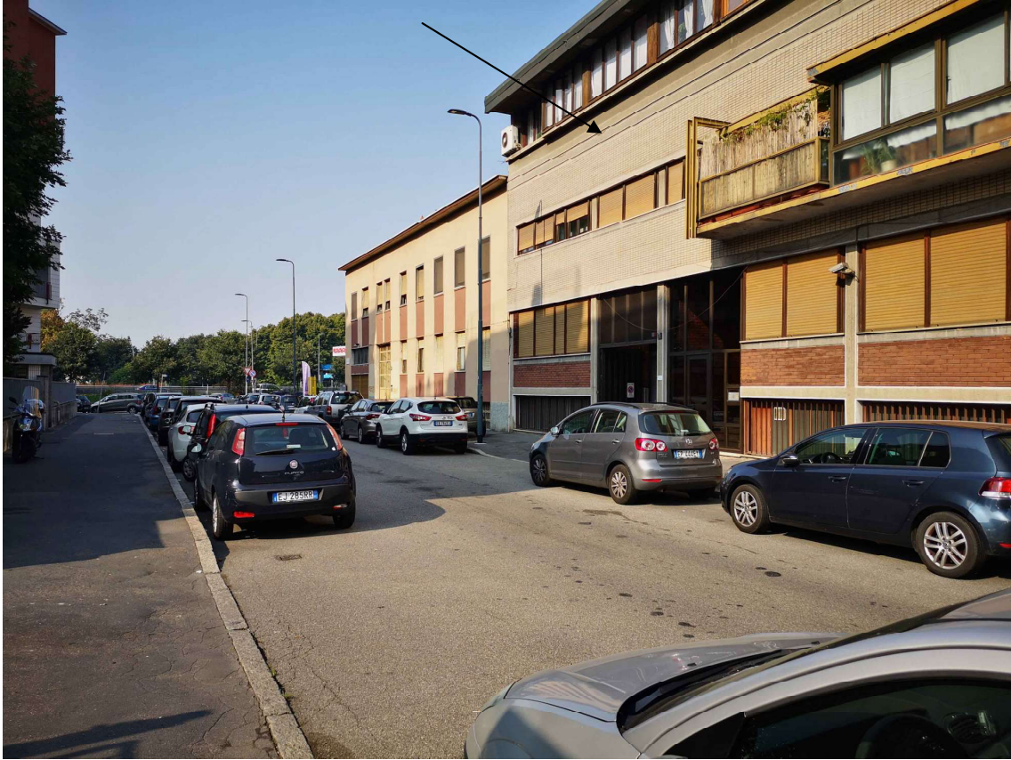
Foto 1 – Vista del fabbricato in esame.
