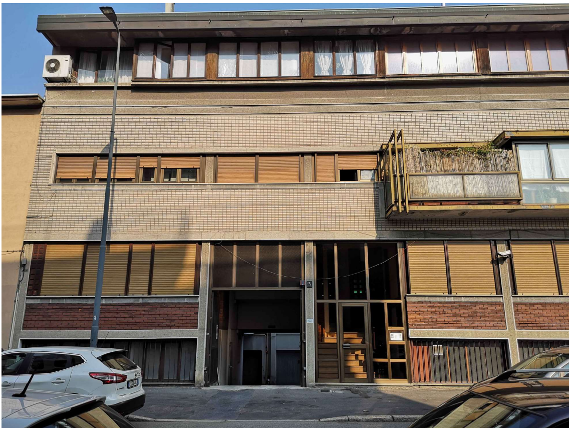
Foto 2 – Vista frontale della facciata su strada.
