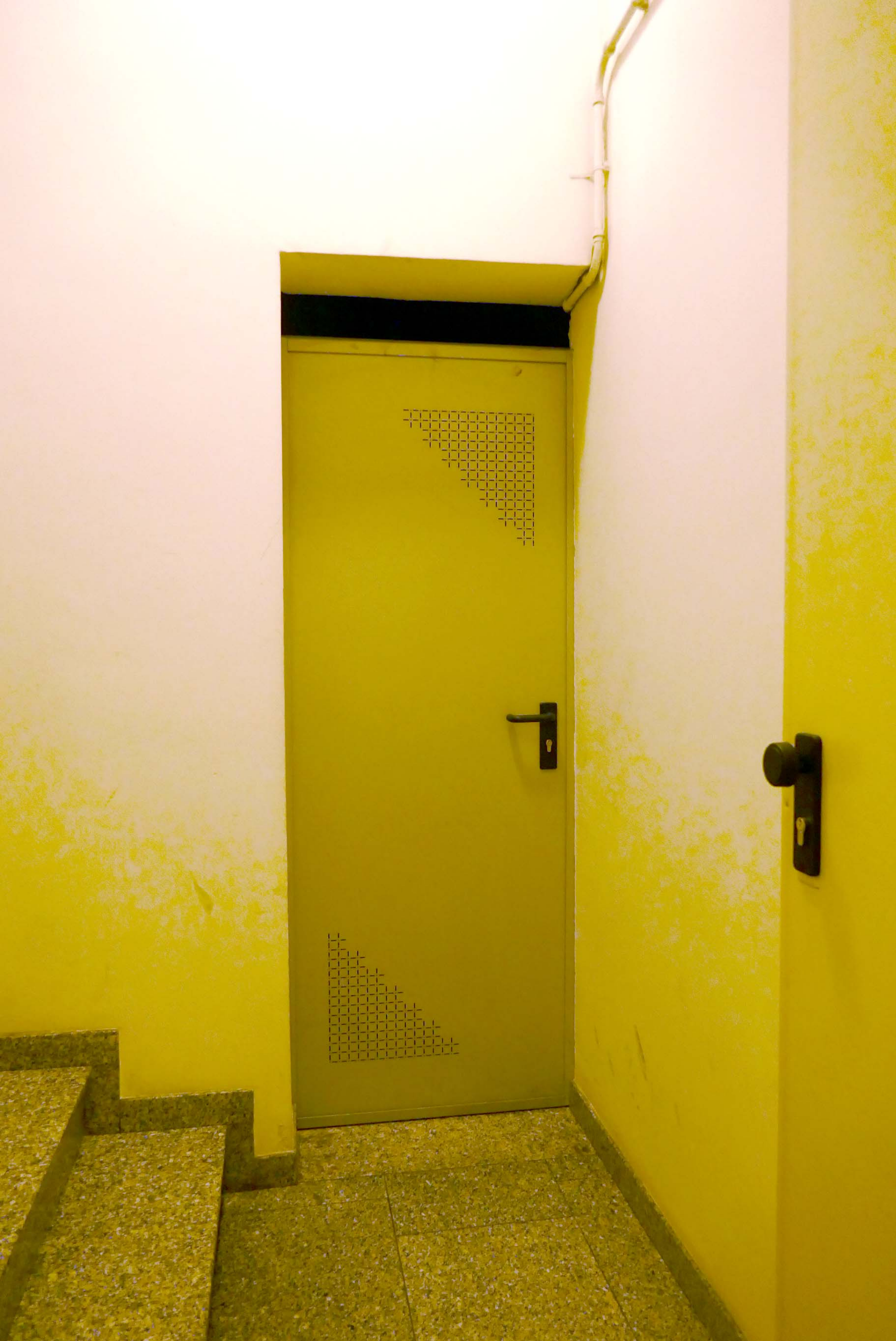
porta della cantina
