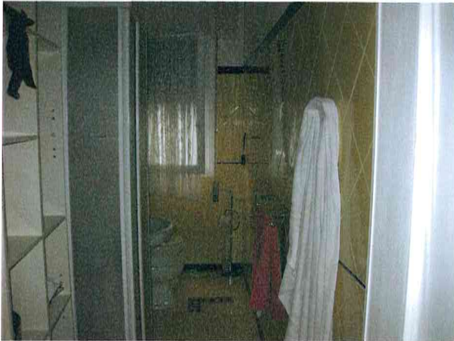
Vista del locale bagno.
