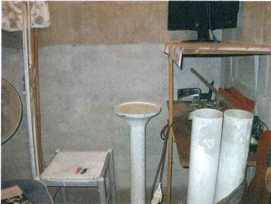
Vista del locale cantina.
