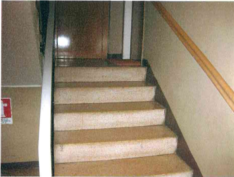
Vista dall'ingresso del vano scala.
