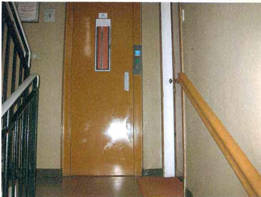
Vista dell'ascensore condominiale.
