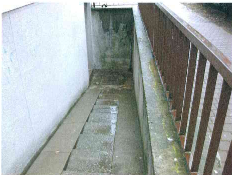
Vista del passaggio di accesso al locale cantina.
