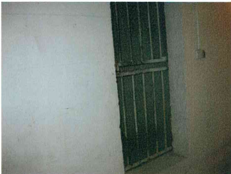
Vista dell'accesso al locale cantina.
