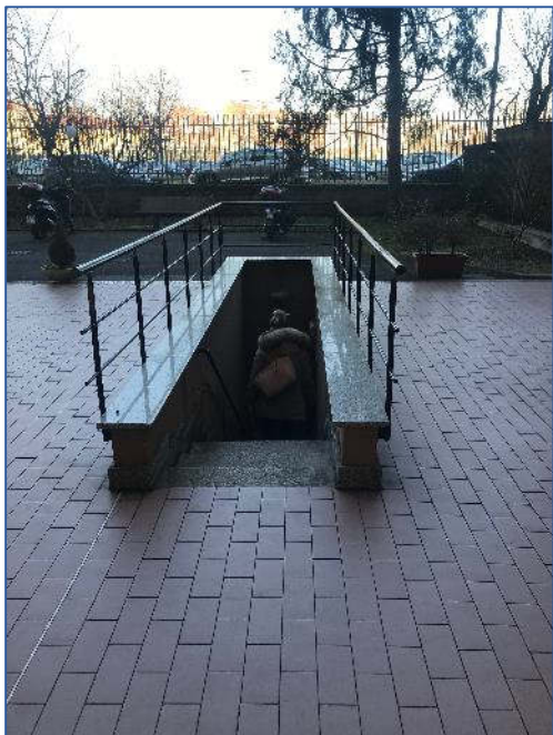
Foto 25 – scala comune per accesso al piano S1
