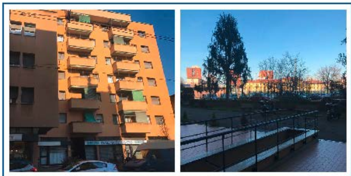
Fig. 3: immobile di via Mambretti 34
