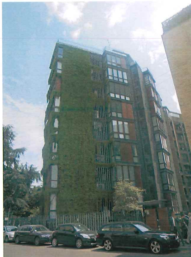
Foto 04 - Condominio di Via Quadronno n.24 Milano
