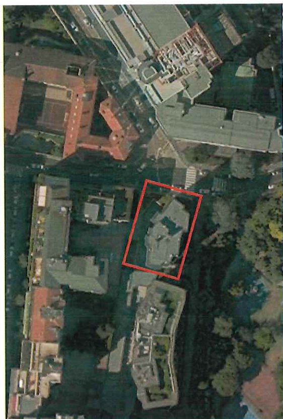
Foto 03 – Condominio di Via Quadronno n.24 Milano
