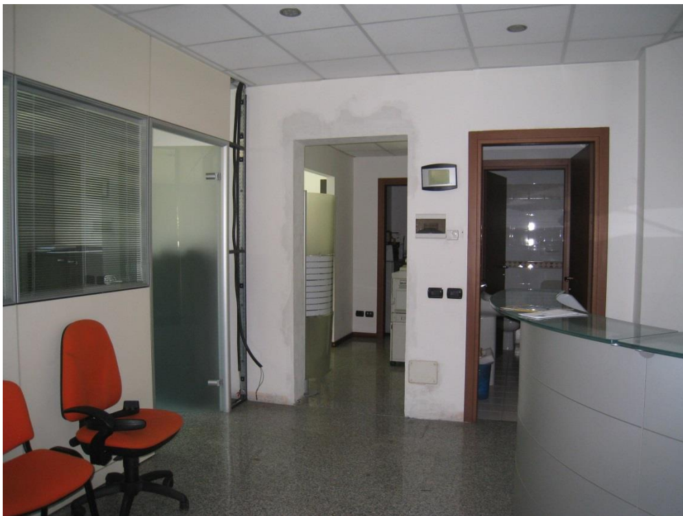
Negozio: locale verso porticato (si noti vano accesso verso unità immobiliare contigua)
