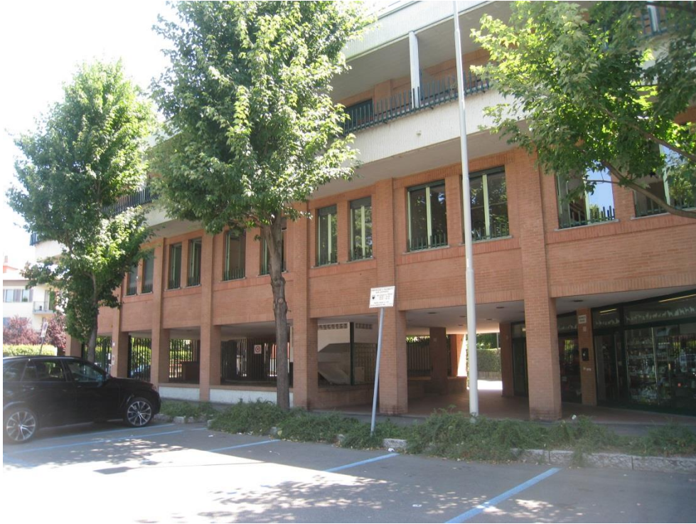
Vista del fabbricato verso Viale delle Rimembranze
