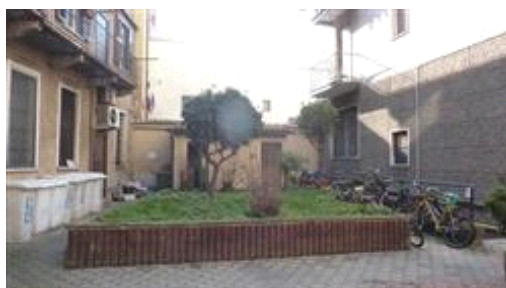
ACCESSO AI MAGAZZINI DA CORTILE
